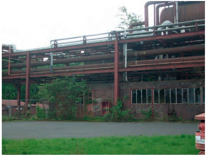
Abb. 2: Zollverein, Kammgebäude, Außenansicht vor Sanierung (2009)
