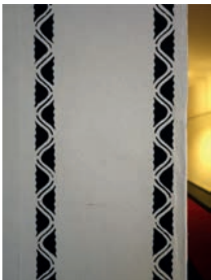
Abb. 220: Albinmüller: Sanatorium Dr. Barner, Braunlage, Neubau (1911–1914): Treppenflur bei den Fremdenzimmern, Detailsicht (2011)
