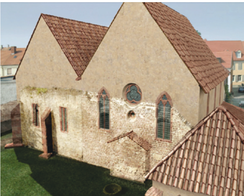
Abb. 3: „Visualisierte Unsicherheit“ in einer digitalen Rekonstruktion der mittelalterlichen Synagoge zu Speyer von Architectura Virtualis GmbH (2004)
