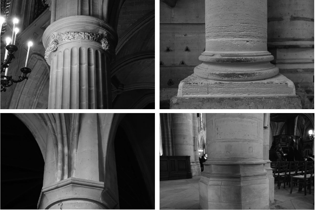
10 Chapiteaux et bases des colonnes du chœur de l'église Saint-Germain l'Auxerrois, Paris
