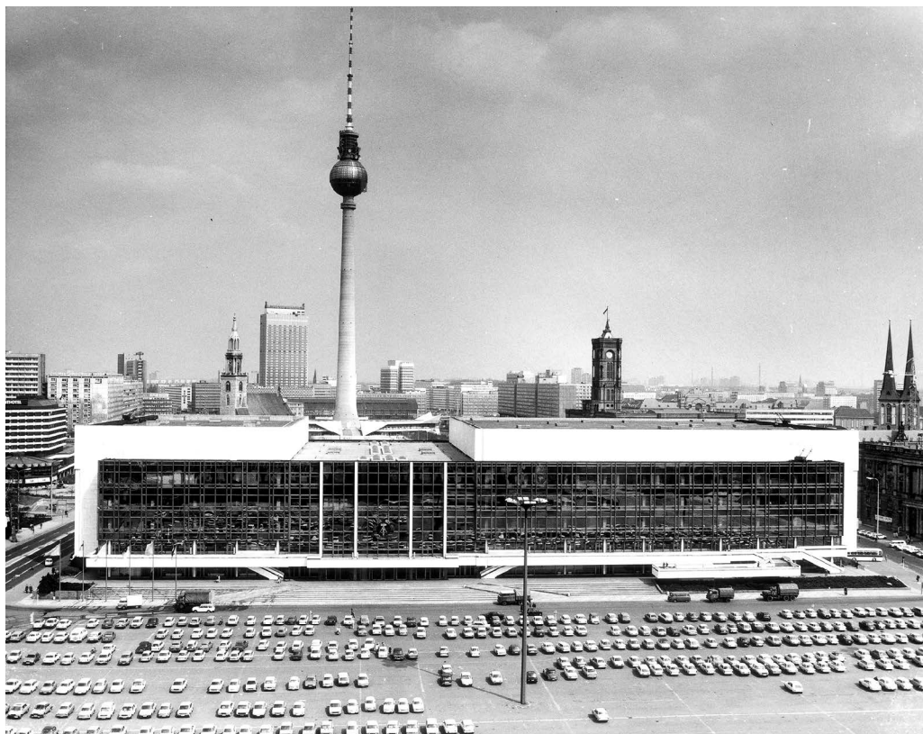
1 Le Palais de la République, lieu culturel et siège de la Volkskammer , le Parlement de l'ancienne RDA, construction : 1973-1976, démolition : 2006-2008, Berlin, Schloßplatz (Marx-Engels-Platz 1950-1994), photo : Heinz Junge (avril 1986)
