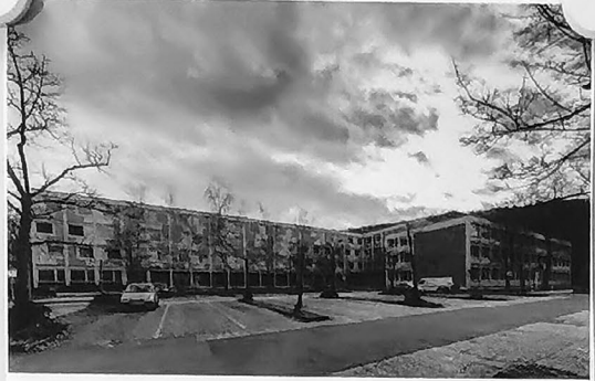
Fallen: eine bestimmte Person in Gebäude B3.1
