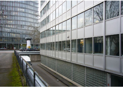
3| Stadt- und Universitätsbibliothek (rechts, Ostfassade), Frankfurt am Main, 1964, Ferdinand Kramer
