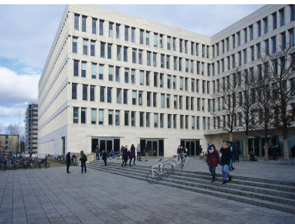
12| PEG-(Psychologie-, Erziehungs- und Gesellschaftswissenschafts-)Gebäude, Campus Westend, Goethe-Universität Frankfurt am Main, 2013, Müller Reimann
