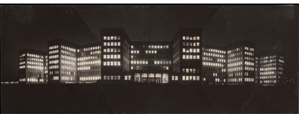
8| Hans Poelzig (1869–1936), I. G.-Farben, Frankfurt am Main, Verwaltungsgebäude. Außenansichten bei Nacht, Foto von Dr. Paul Wolff & Tritschler
