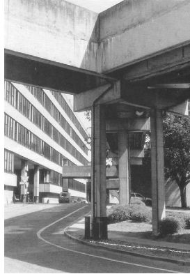
16| University of East Anglia, Fußgängerbrücke von unten
