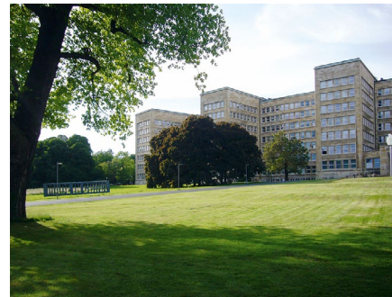
30| IG-Farben-Gebäude, Frankfurt am Main, 1931, Hans Poelzig, 1998–2001 durch Dissing und Weitling umgebaut und saniert (ab 2001 Goethe-Universität Frankfurt am Main)
