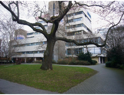
15| Sozialzentrum/Neue Mensa, Campus Bockenheim der Goethe-Universität Frankfurt am Main, 1968, Heinrich Nitschke
