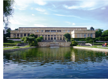
9| Casino-Gebäude, Teil des IG-Farben-Ensembles, Frankfurt am Main, 1931, Hans Poelzig, 1998–2001 durch Dissing und Weitling umgebaut und saniert (ab 2001 Goethe-Universität Frankfurt am Main)
