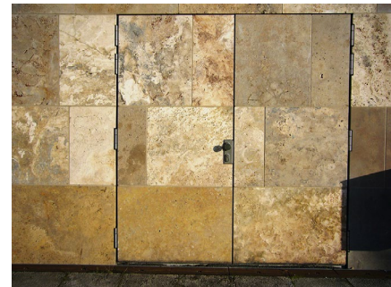
10| Servicetür und Fassade aus Naturstein (Travertin), Hörsaalzentrum, Campus Westend, Goethe-Universität Frankfurt am Main, 2008, Ferdinand Heide
