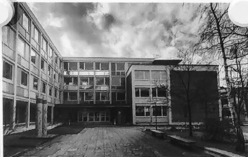
Schwert: Gebäude B3.1 wegen des Prüfungssekretariats dort
