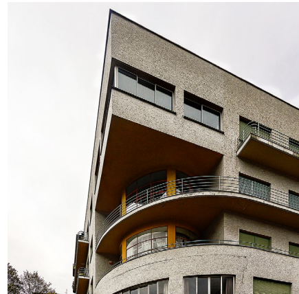
32| Novocomum (Nordwestecke), Como, 1929, Giuseppe Terragni
