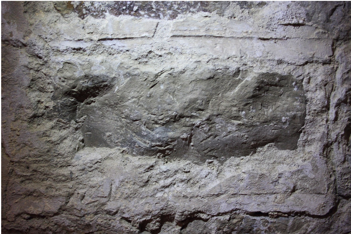
Abb. 41 Santa Croce, Sakristei (ehem. Außenseite, heute in der Cappella del Noviziato), Mauerwerk aus unregelmäßigen Quadern, Fugen mit Kellenstrich, Aufnahme 2014
