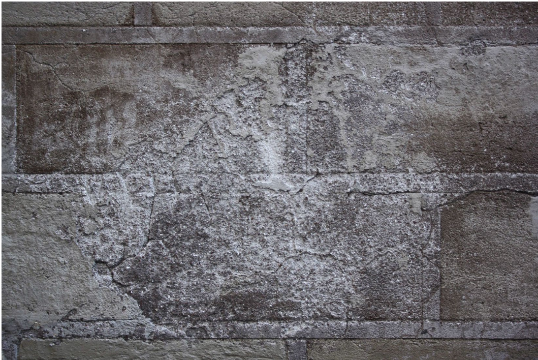
Abb. 199 Rom, Casina di Cardinal Bessarione, Mauer zur Via di Porta San Sebastiano, Sgraffito-Dekoration (restauriert, partiell rekonstruiert), Detail, Aufnahme 2013
