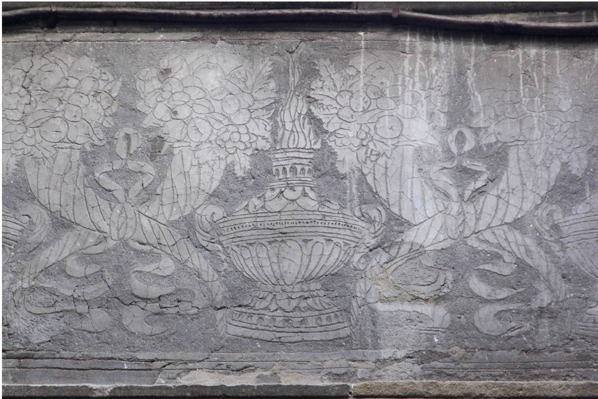
Abb. 115 Palazzo Capponi, Innenhof, Nordseite, Erdgeschoss, Sgraffito-Dekoration (restauriert), Fries mit Füllhörnern und Flammenvasen (und Nachlässigkeiten in der Ausführung), Aufnahme 2012
