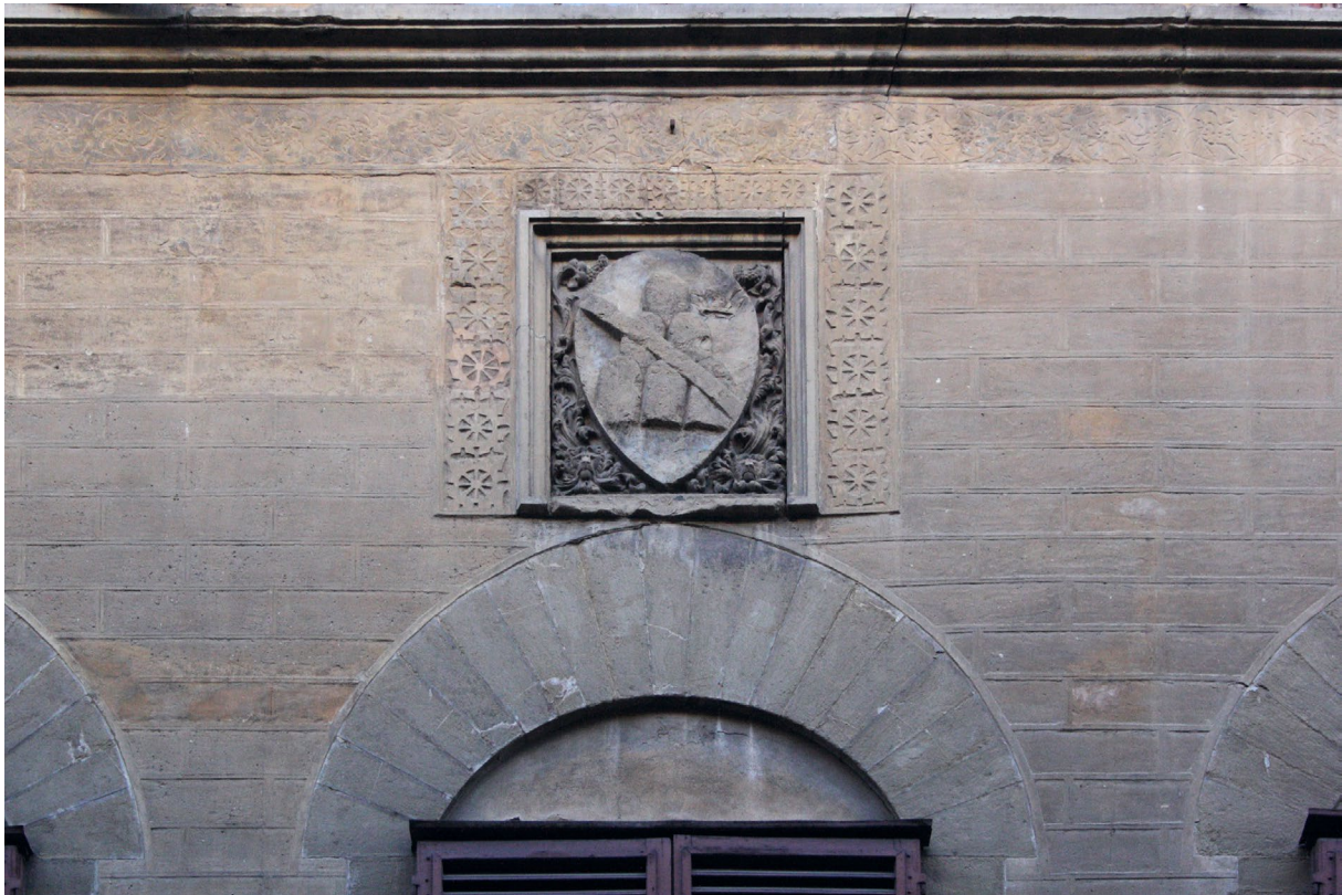
Abb. 25 Palazzo Corbinelli, Fassade zur Via Maggio, 1. Obergeschoss, Sgraffito-Dekoration (zum Teil rekonstruiert), Aufnahme 2012
