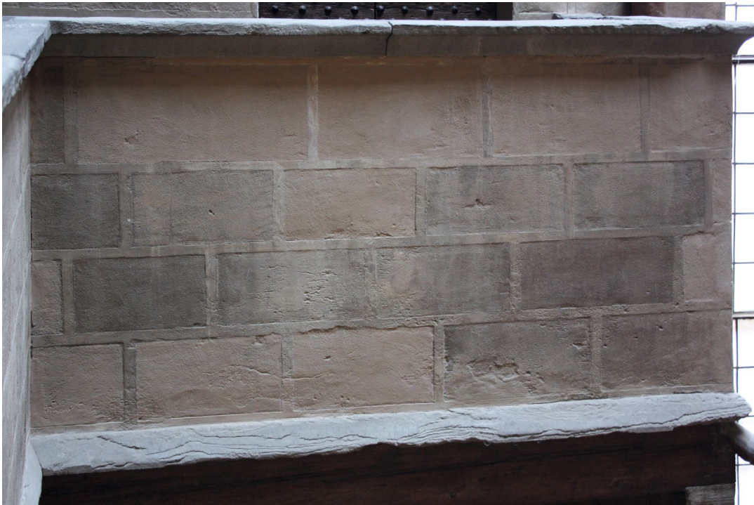
Abb. 31 Palazzo Davizzi, Innenhof, 2. Obergeschoss, Brüstung des ballatoio mit Sgraffito-Dekoration (restauriert, rekonstruiert, Flächen in verschiedenen Tönen überfasst), Aufnahme 2015
