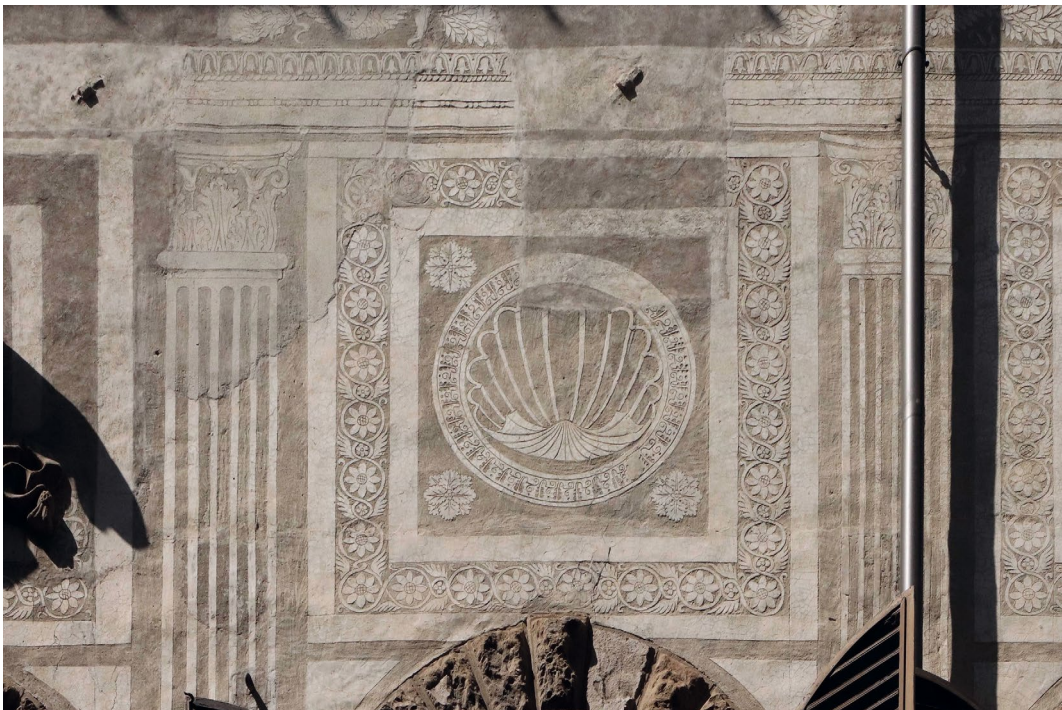
Abb. 77 Palazzo Dietisalvi Neroni, Fassade zur Via de' Ginori, 1. Obergeschoss, Sgraffito-Dekoration (restauriert), Zierfeld mit Muscheltondo, Aufnahme 2019
