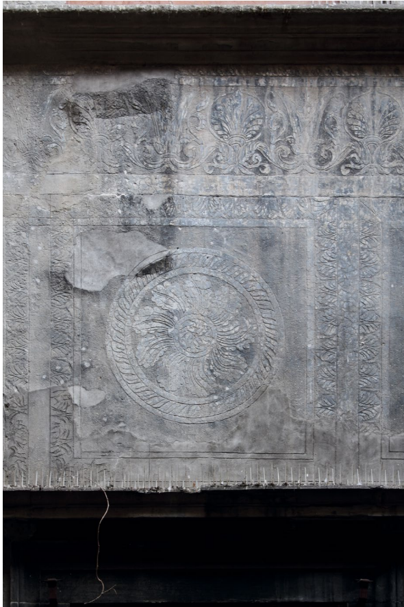
Abb. 96 Palazzo Spinelli, Innenhof, 1. Obergeschoss, Südseite, Sgraffito-Dekoration (restauriert) mit Rosettenfeld und Fries, Aufnahme 2014
