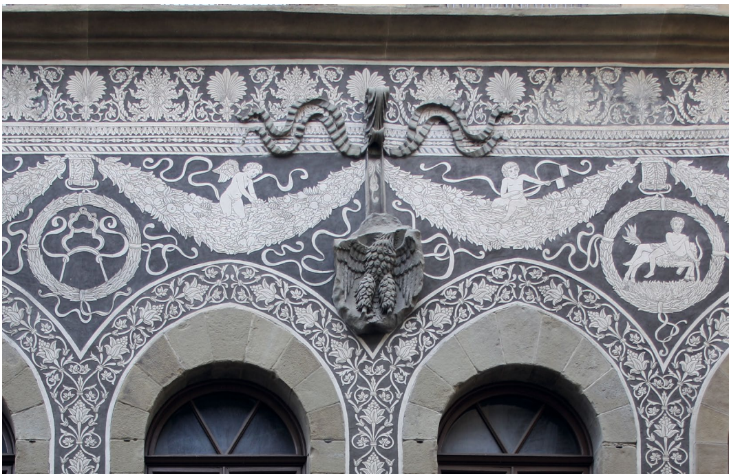
Abb. 86 Palazzo Benizzi, Fassade zur Via de' Guicciardini, 1. Obergeschoss, Sgraffito-Dekoration (rekonstruiert, restauriert), Wappenrelief, Macigno , Aufnahme 2011
