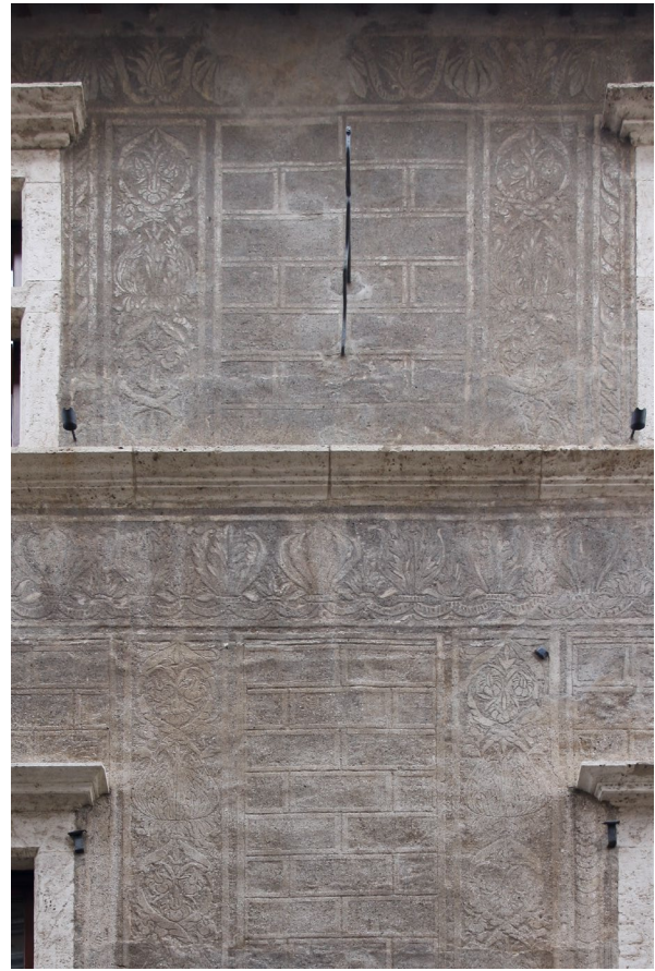
Abb. 207 Pienza, Palazzo Ammannati, Fassade zum Corso Rossellino, 1. und 2. Obergeschoss, Sgraffito-Dekoration (restauriert), Aufnahme 2015
