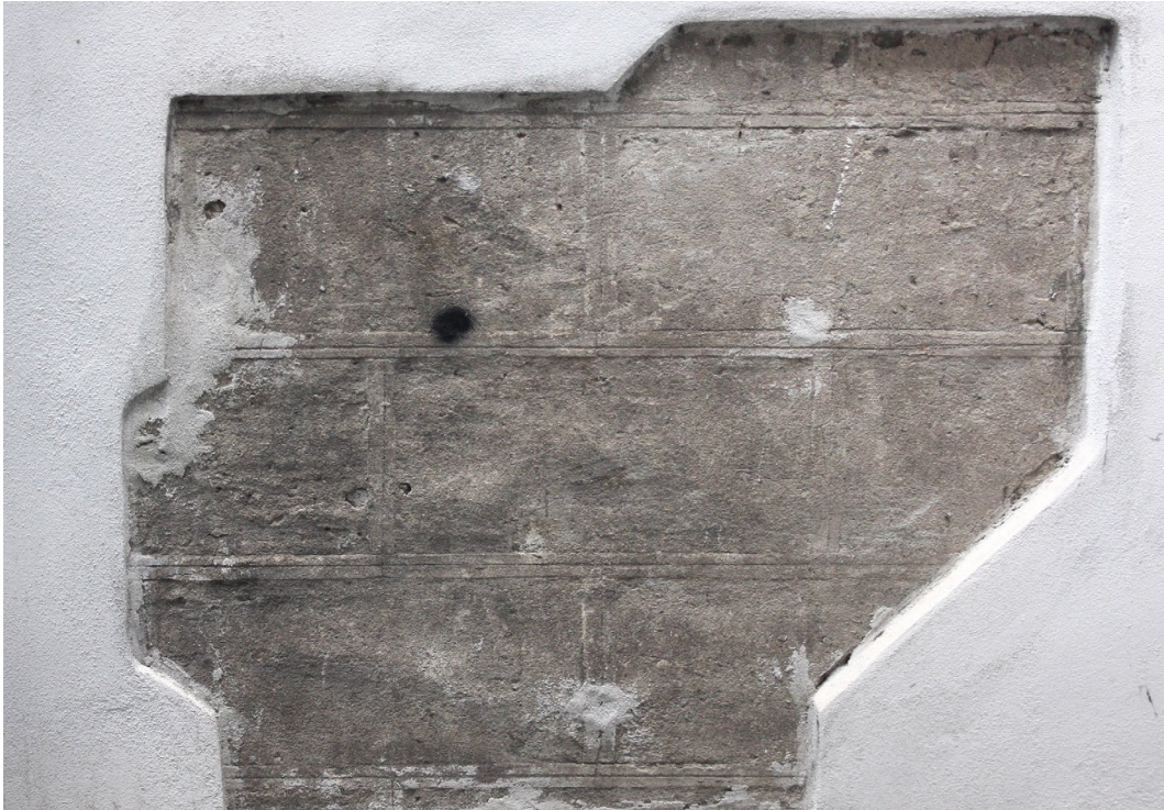
Abb. 5 Palazzo Giandonati, südliche Gebäudeseite (von Palazzo Canacci verdeckt), 2. Obergeschoss, Befundfreilegung mit Fragment der bauzeitlichen Sgraffito-Dekoration, Aufnahme 2016
