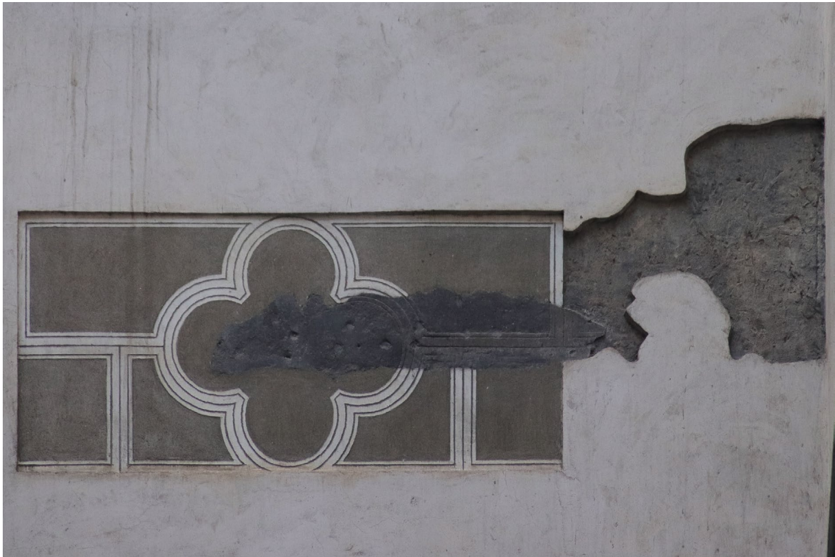
Abb. 100 Palazzo della Signoria, Innenhof, 1. Obergeschoss, Nordseite, Befundfenster mit Fragment der Sgraffito-Dekoration, anschließende Wandgestaltung rekonstruiert, Aufnahme 2018
