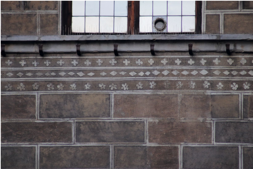
Abb. 58 Palazzo Giandonati, Fassade zur Piazza San Biagio, 1. Obergeschoss, Sgraffito-Fries (rekonstruiert) unterhalb des Macigno -Gesimsbands, Aufnahme 2018
