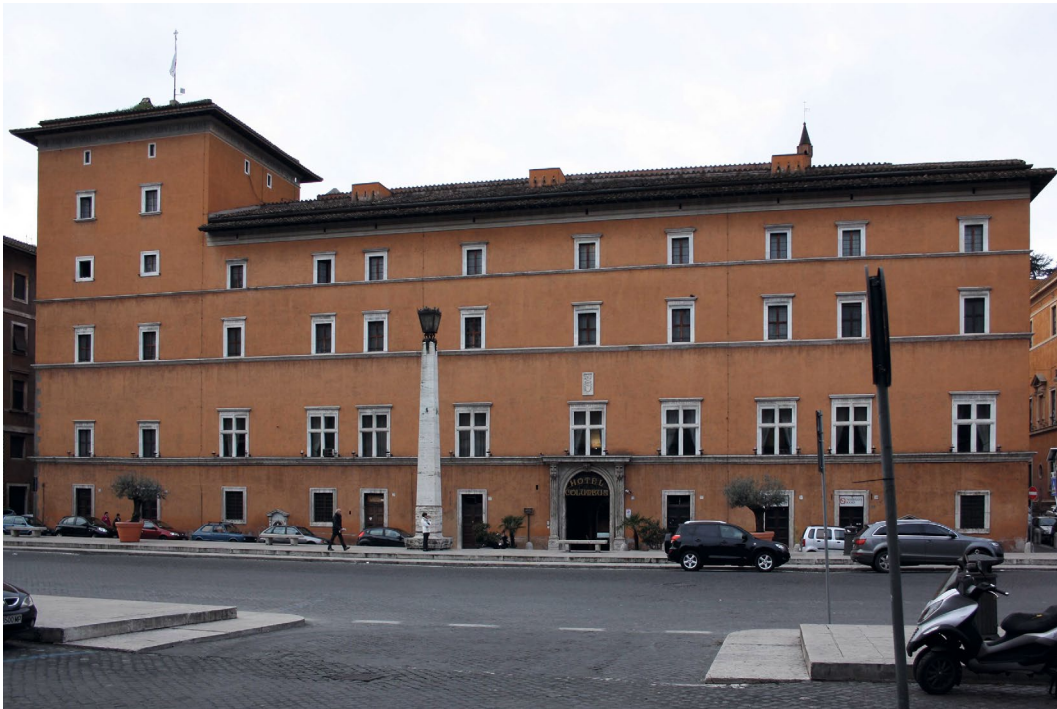
Abb. 200 Rom, Palazzo di Domenico della Rovere/Palazzo dei Penitenzieri, Fassade zur (heutigen) Via della Conciliazione, Aufnahme 2013
