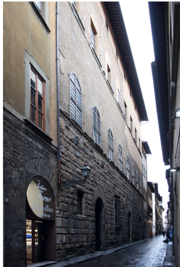
Abb. 179 Palazzo degli Alessandri, Fassade zum Borgo degli Albizzi, Quadermauerwerk im 1. Obergeschoss und zum Teil im 2. Obergeschoss mit planer Oberfläche, Aufnahme 2018
