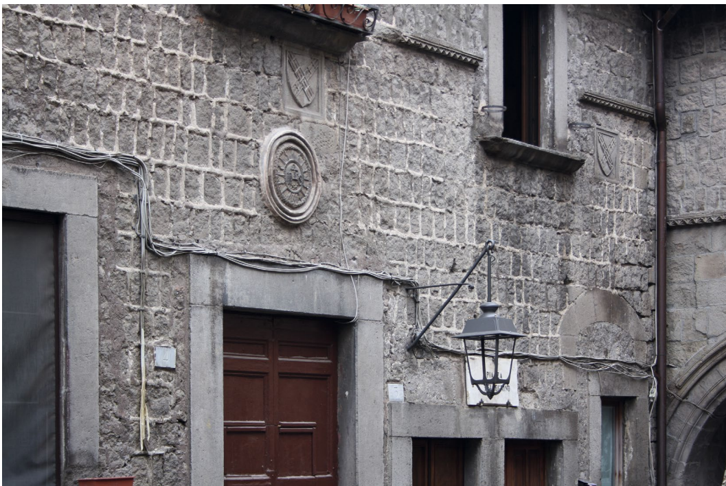
Abb. 48 Viterbo, Piazza San Pellegrino, Fassade mit Bandfugen-/Sgraffito-Gestaltung, Aufnahme 2015
