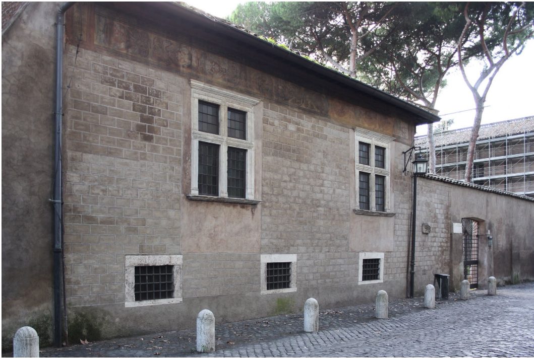
Abb. 198 Rom, Casina di Cardinal Bessarione, Fassade und Mauer zur Via di Porta San Sebastiano, Sgraffito-Dekoration (restauriert, größtenteils rekonstruiert), Aufnahme 2013
