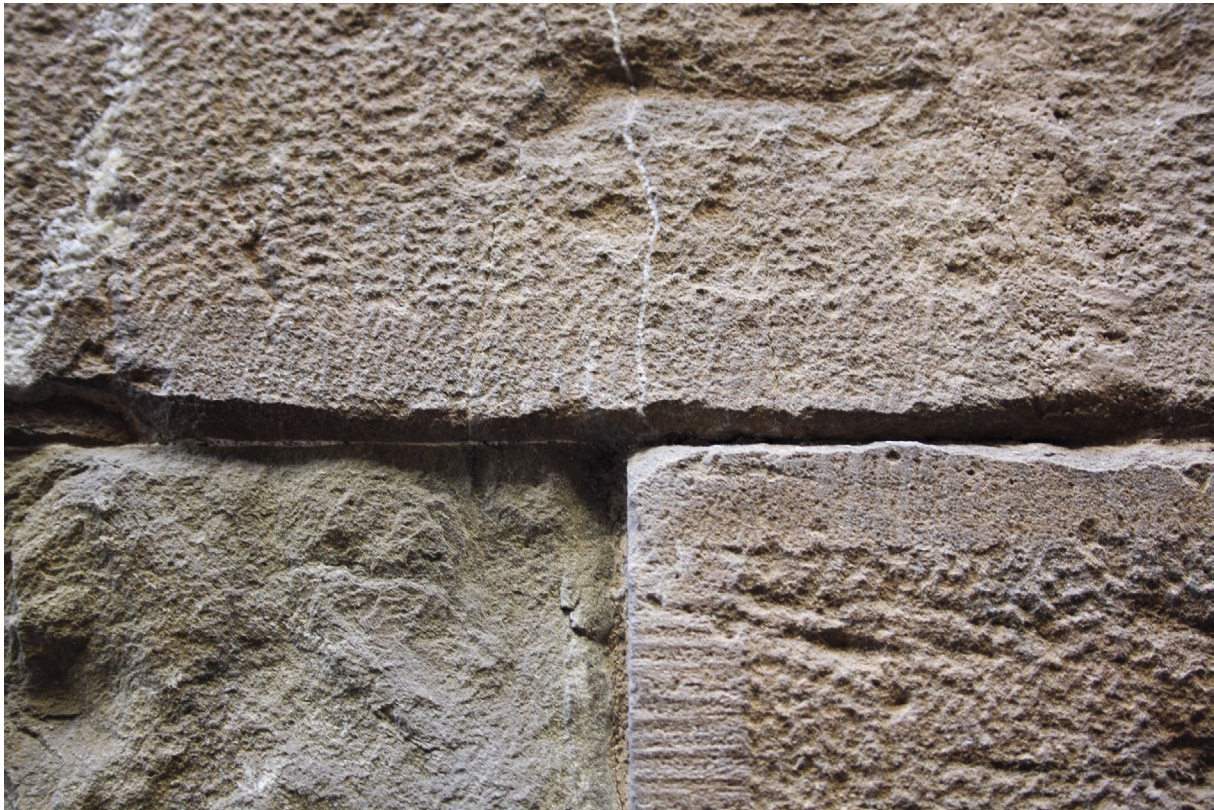
Abb. 165 Quadermauerwerk aus Pietra forte , Quader mit Randschlag
