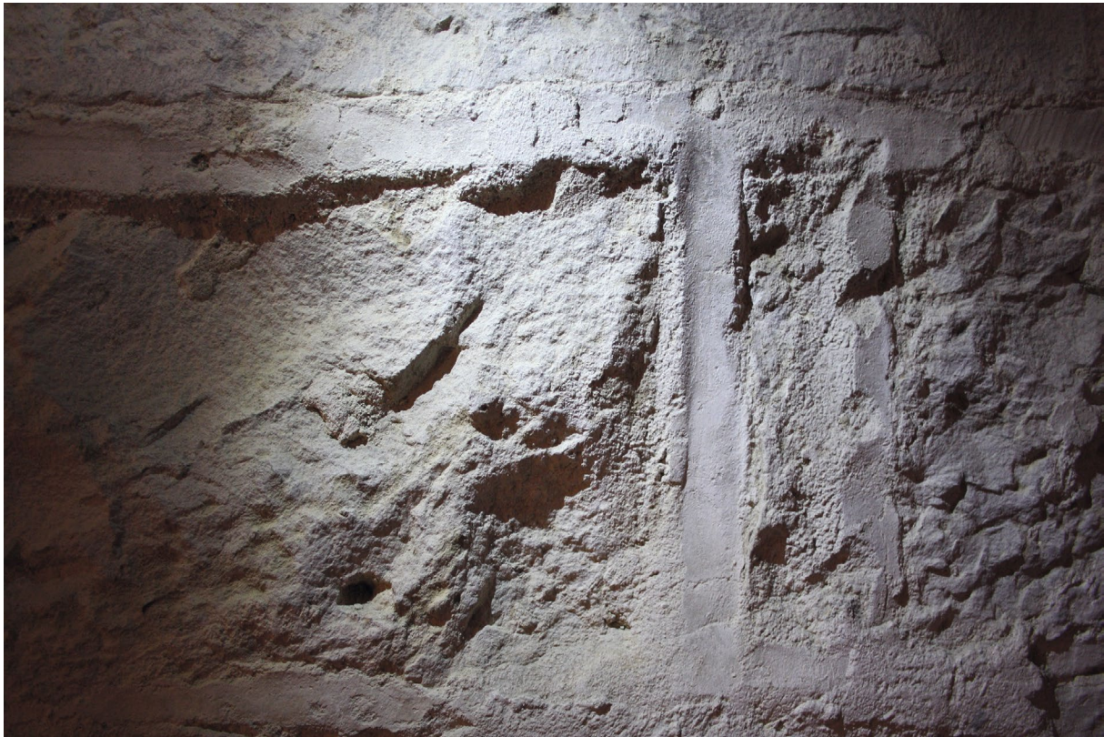
Abb. 42 Santa Croce, Querhaus, Erdgeschoss, Südwestecke, verputztes unregelmäßiges Mauerwerk mit Kellenstrich, Aufnahme 2014
