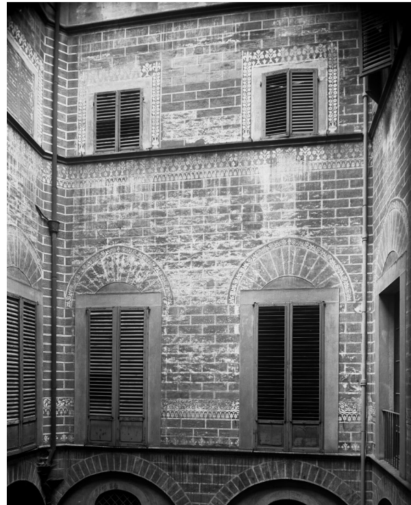
Abb. 24 Palazzo Da Uzzano, Innenhof, Ostseite, Sgraffito-Dekoration (nach der Rekonstruktion/Restaurierung um 1910), Aufnahme Anfang 1930er Jahre (?)
