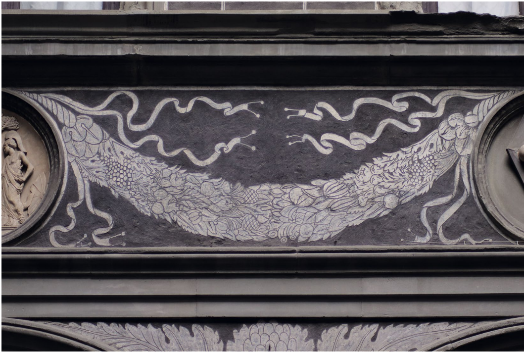
Abb. 103 Palazzo Medici, Innenhof, Westseite, Erdgeschoss, Fries mit Marmorreliefs und Sgraffito-Dekoration (restauriert, partiell rekonstruiert), Aufnahme 2018
