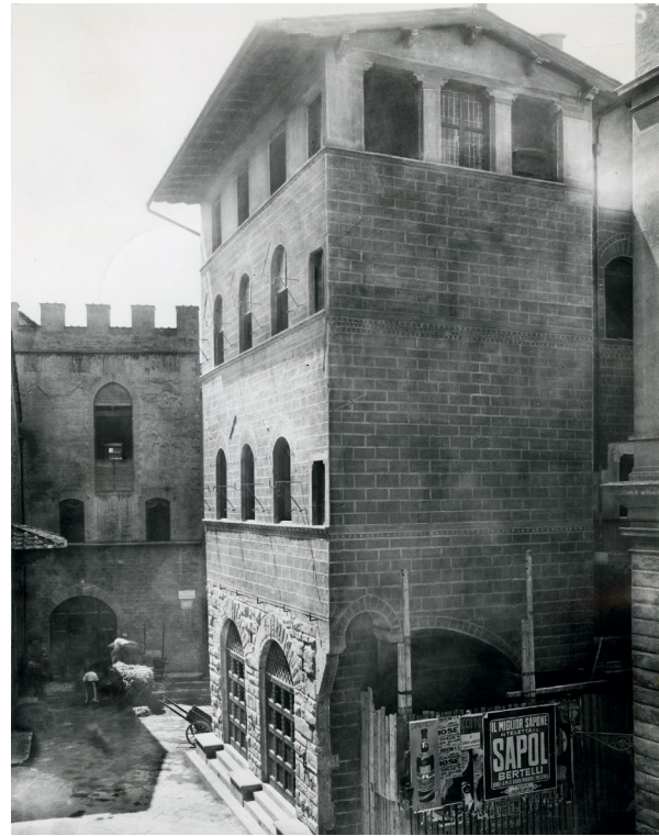
Abb. 20 Palazzo Giandonati, Fassade zur Piazza San Biagio, Erdgeschoss, Nordost-Ecke, Aufnahme am Ende der Neugestaltung, wahrscheinlich 1914
