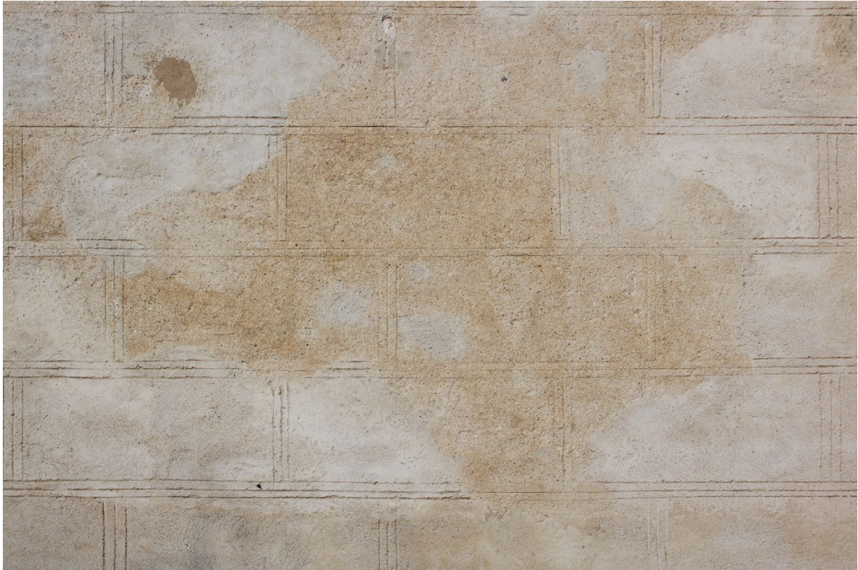
Abb. 203 Pienza, Palazzo Piccolomini, Küchentrakt, Südseite, Sgraffito-Dekoration (restauriert, zum Teil rekonstruiert), Detail, Aufnahme 2015
