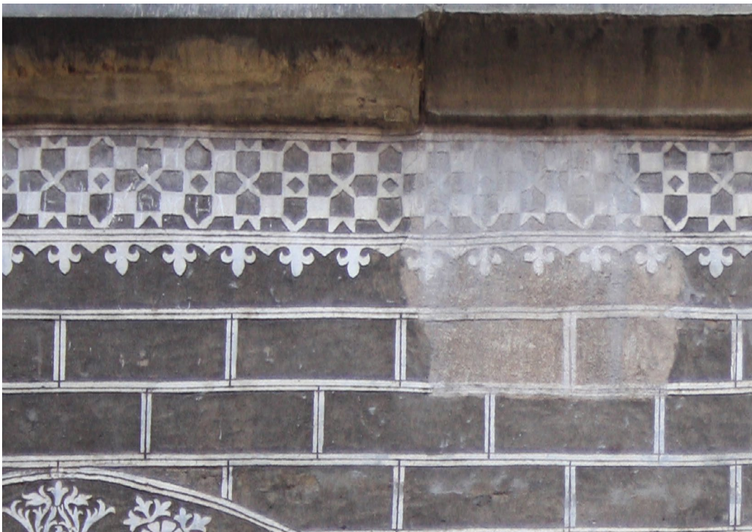
Abb. 61 Palazzo Corsi, Fassade, Erdgeschoss, Sgraffito-Dekoration (überwiegend rekonstruiert, Fragmente der Quattrocento-Gestaltung integriert) mit Zierband unter dem Macigno -Gesims, Aufnahme 2018
