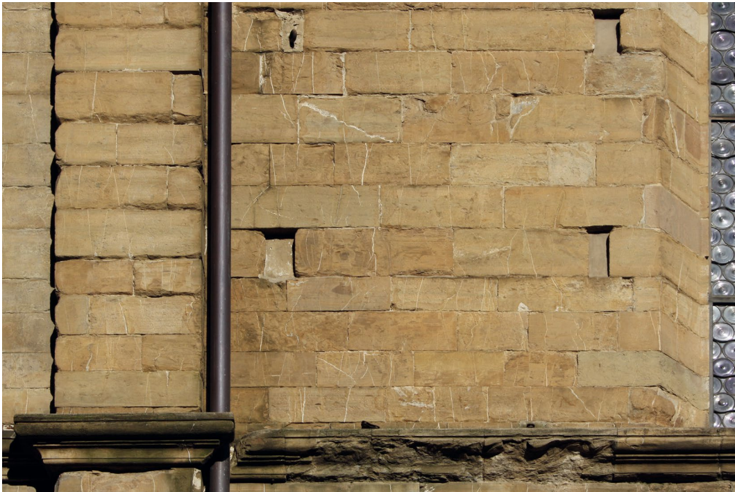
Abb. 166 Badia Fiorentina, Fassade zur Via del Proconsolo, Quadermauerwerk mit planer Oberfläche, Aufnahme 2012
