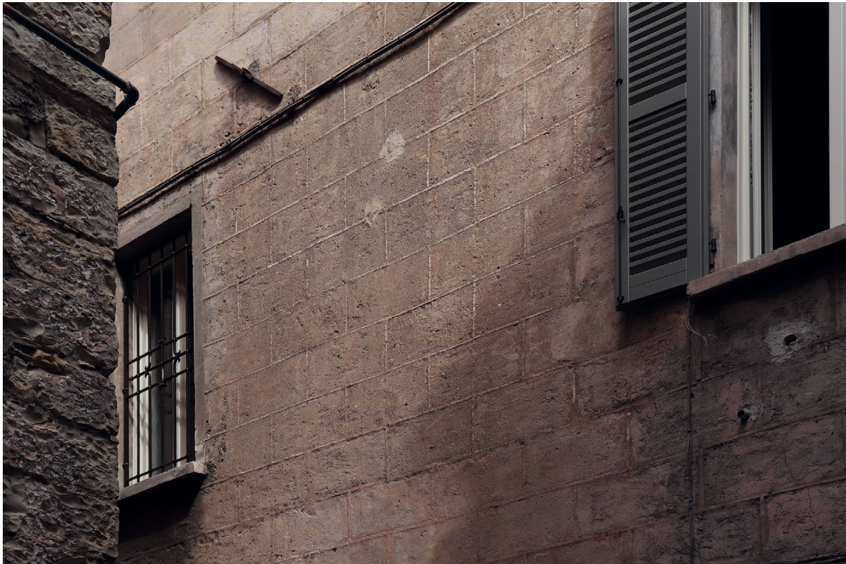
Abb. 237 Brescia, Casa del Moretto, Südseite, Sgraffito-Dekoration (restauriert), Detail, Aufnahme 2018
