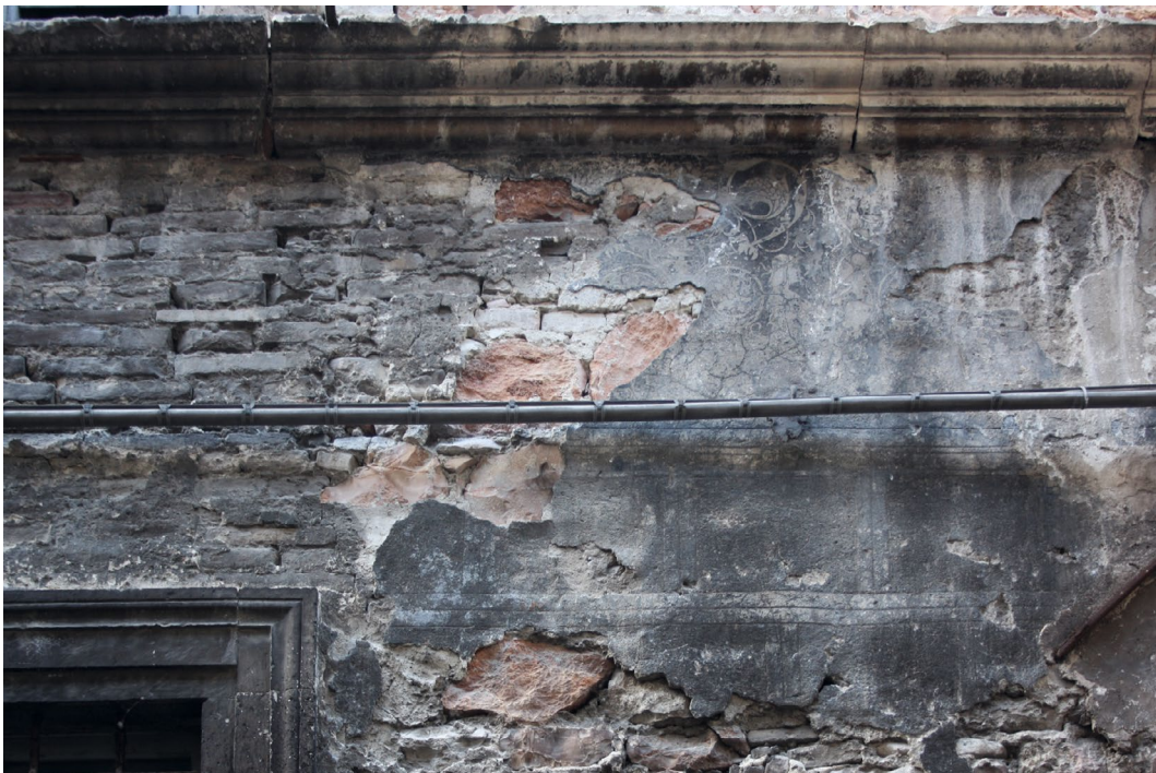
Abb. 221 Cagli, Palazzo Tirrani, Fassade zur Via Lapis, Erdgeschoss, Reste der Sgraffito-Dekoration, Aufnahme 2016
