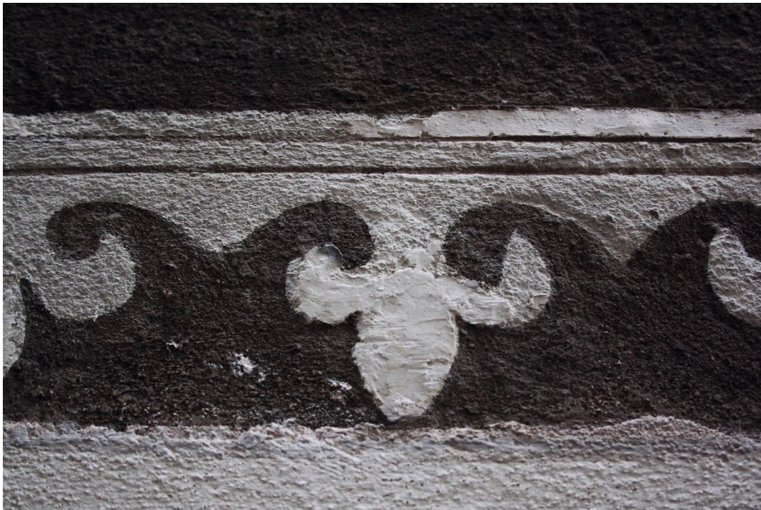
Abb. 30 Palazzo Corsi, Fassade zum Borgo Santa Croce, Sgraffito-Dekoration (rekonstruiert, restauriert), Sockelabschluss mit nachgemalter Ornamentik, Aufnahme 2017
