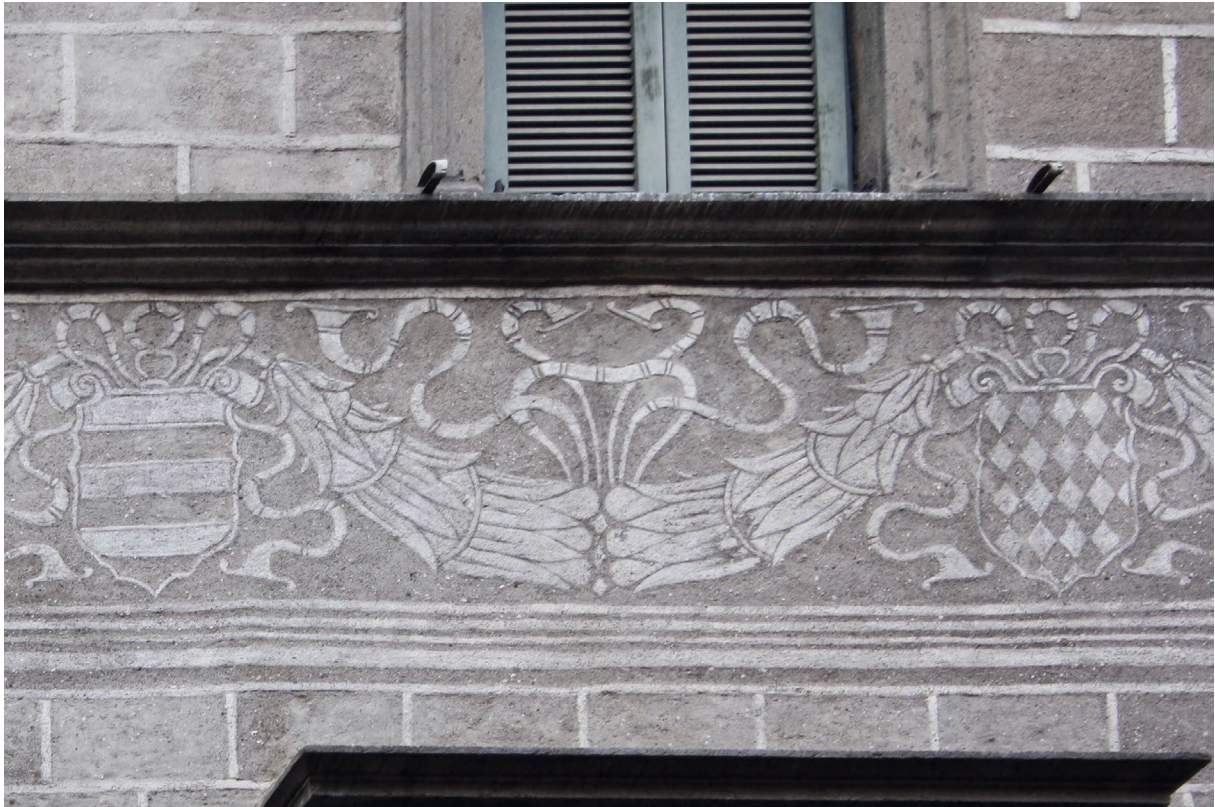
Abb. 218 Viterbo, Palazzo Calabresi, Fassade zur Via Calabresi, 1. Obergeschoss, Sgraffito-Dekoration (restauriert/rekonstruiert), Aufnahme 2015
