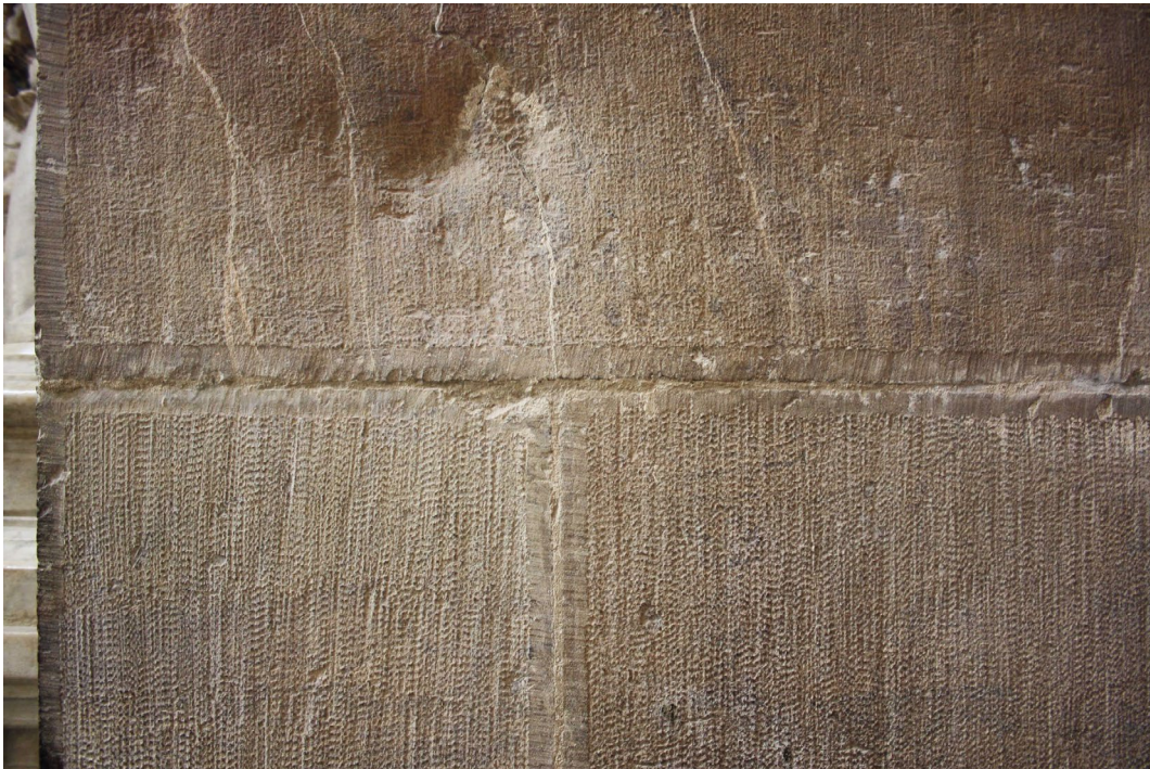
Abb. 56 Santa Croce, Querhaus, Pfeiler, Pietra forte -Quader mit Randschlag, Aufnahme 2012
