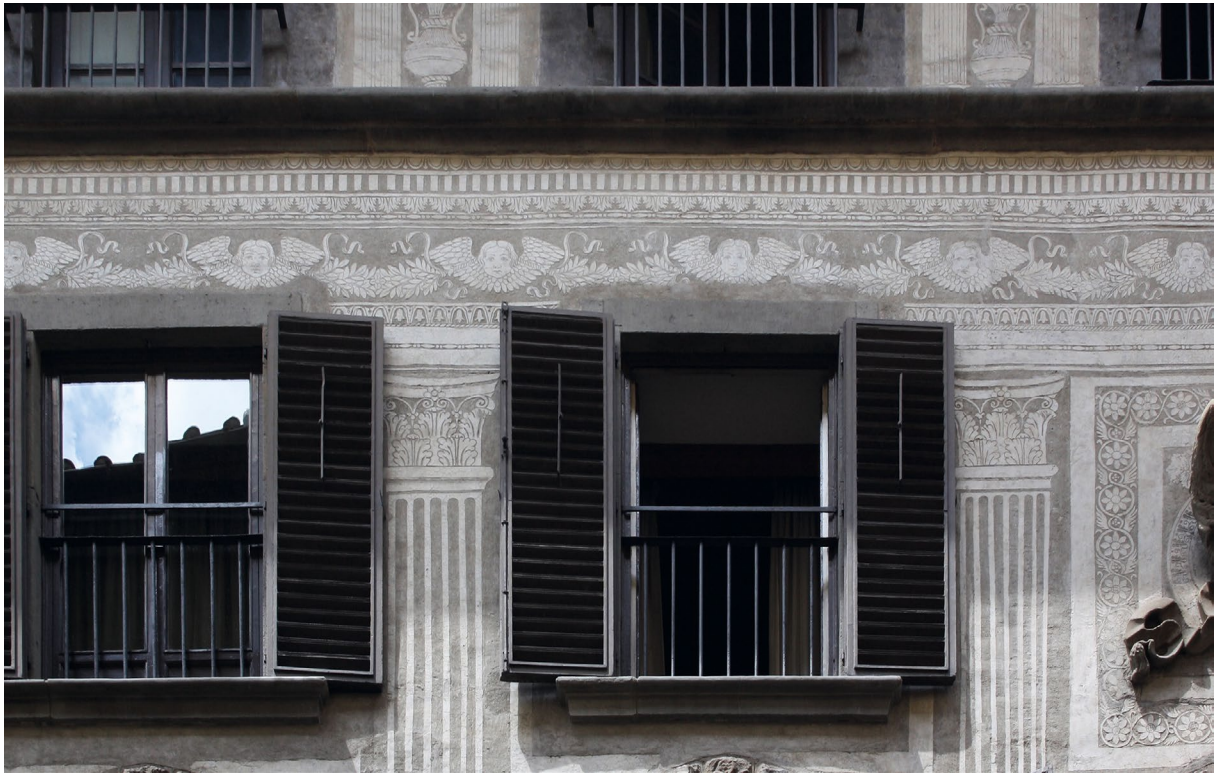
Abb. 33 Palazzo Dietisalvi Neroni, Fassade zur Via de' Ginori, 1. Obergeschoss, Sgraffito-Dekoration (restauriert), Detail, Aufnahme 2011
