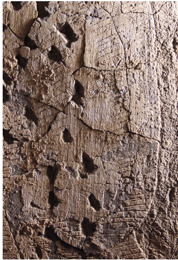
Abb. 111 Villa Sassetti/La Pietra, ehemaliger Innenhof, Südostseite, 1. Obergeschoss, Sgraffito-Dekoration, Detail mit Pinselspuren, Aufnahme 2012
