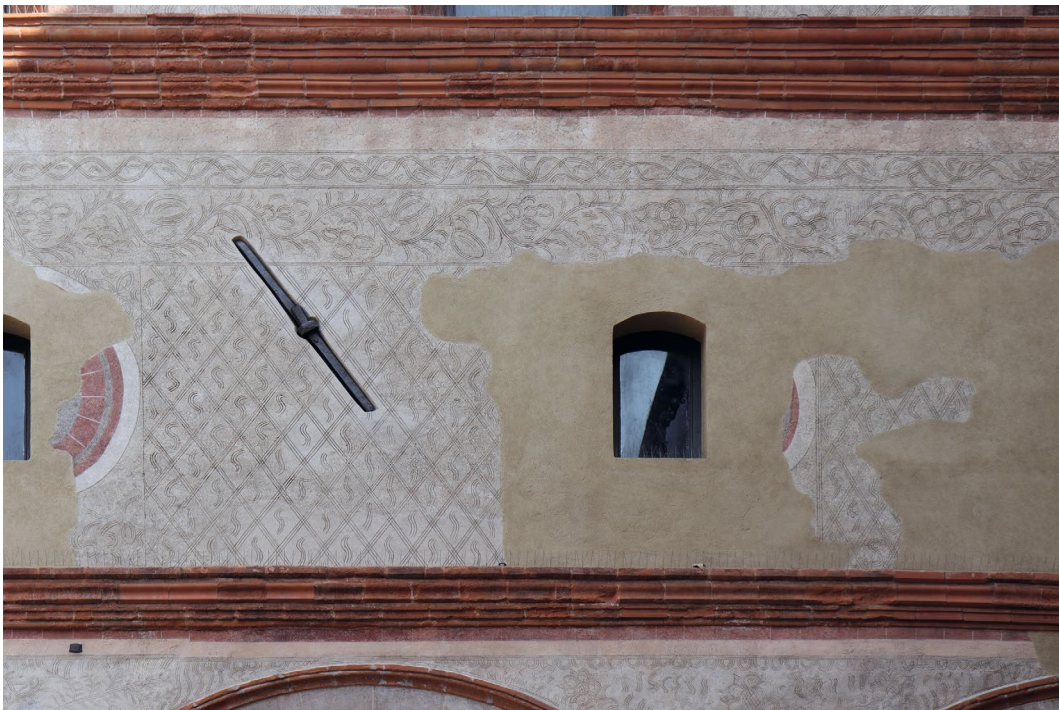
Abb. 227 Mailand, Castello di Porta Giovia, Cortile della Rocchetta, Nordostseite, Mezzanin, Sgraffito-Dekoration (restauriert), Aufnahme 2018
