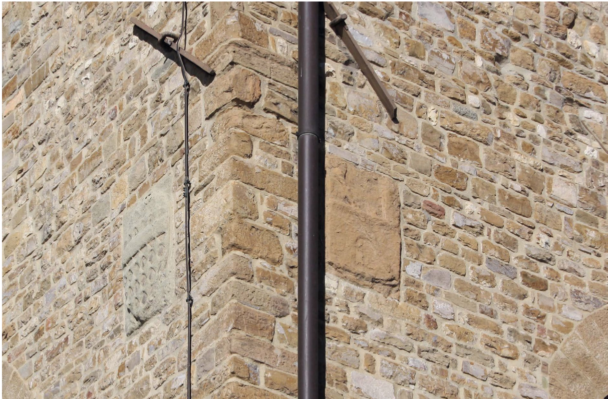
Abb. 109 Palazzo Castellani, Ansicht von Südosten, 1./2. Obergeschoss, filaretto -Mauerwerk, Aufnahme 2015
