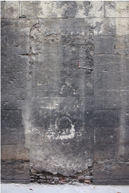
Abb. 123 Gebäude in der Via de' Bardi 15, Fassade, vermauerte Türöffnung, Sgraffito-Dekoration, Aufnahme 2017
