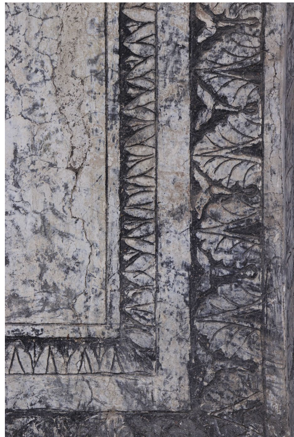
Abb. 26 Palazzo Spinelli, Innenhof, 2. Obergeschoss, Westseite, Sgraffito-Fries (restauriert), Aufnahme 2018
