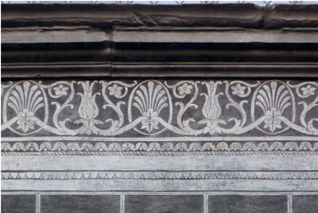
Abb. 102 Palazzo Medici, Innenhof, 1. Obergeschoss, Gebälk mit Sgraffito-Dekoration (restauriert, partiell rekonstruiert) und Macigno -Gesims, Aufnahme 2012
