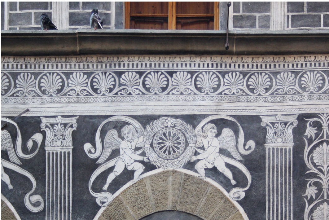
Abb. 88 Palazzo Nasi, Fassade zur Via San Niccolò, 1. Obergeschoss, Sgraffito-Dekoration mit Pilaster-Gebälk-Gliederung und zwei einen Kranz haltenden Putten, Aufnahme 2012
