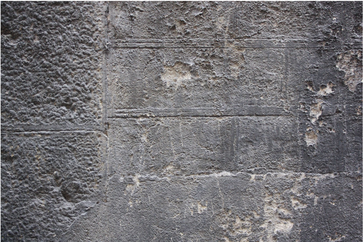
Abb. 124 Gebäude in der Via de' Bardi 15, Fassade, vermauerte Türöffnung, Sgraffito-Dekoration, Detail, Aufnahme 2017
