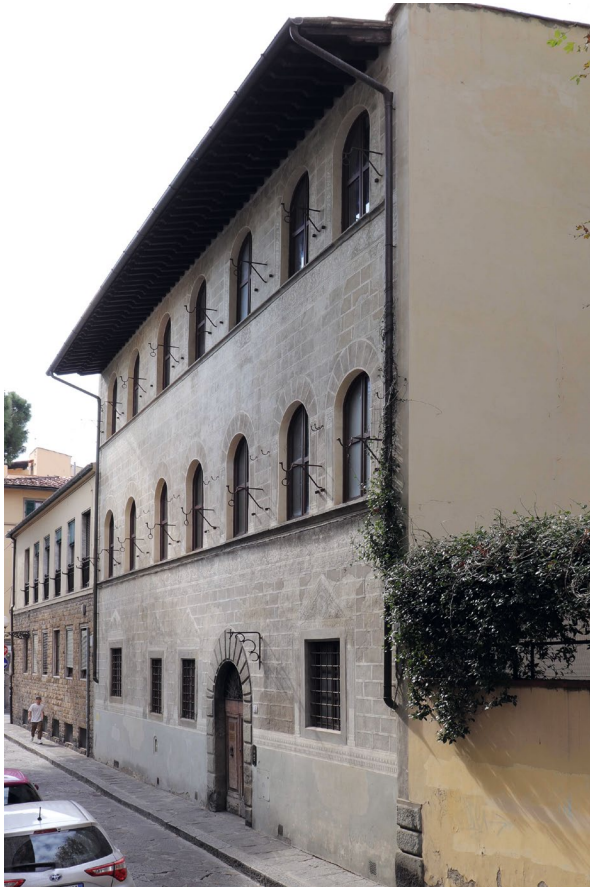
Abb. 70 Palazzo Lapi, Fassade zur Via Michelangelo Buonarroti, Aufnahme 2020
