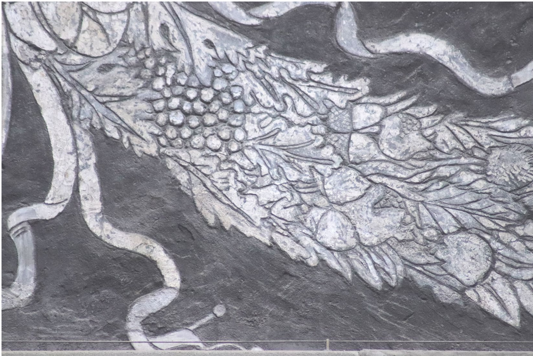
Abb. 117 Palazzo Medici, Innenhof, Erdgeschoss, Sgraffito-Dekoration (restauriert, partiell rekonstruiert), Detail mit deutlichen Schabspuren, Aufnahme 2018
