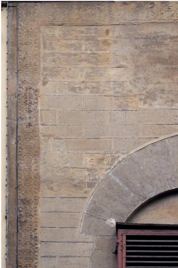
Abb. 68 Palazzo Corbinelli, Fassade zur Via Maggio, 1. Obergeschoss, Sgraffito-Dekoration (zum Teil rekonstruiert), nördlicher Wandabschluss mit ornamentierter Lisene, Aufnahme 2012
