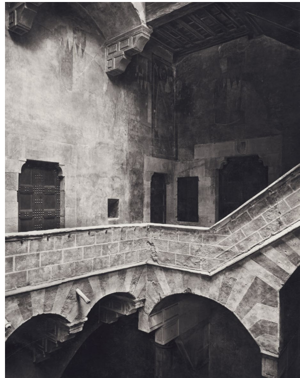
Abb. 1 Palazzo Davizzi, Innenhof, 1. Obergeschoss, Brüstung des ballatoio mit restaurierter Sgraffito-Dekoration, Aufnahmedatum unbekannt (nach Restaurierung 1905–1909)
