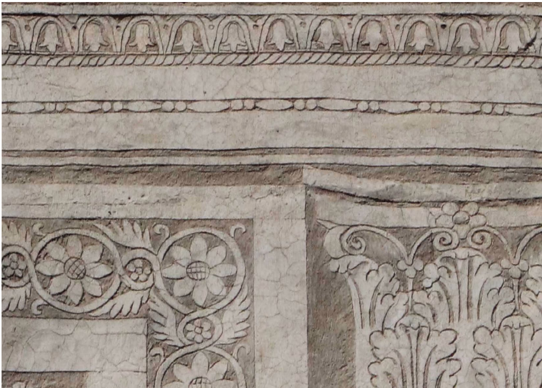
Abb. 118 Palazzo Dietisalvi Neroni, Fassade zur Via de' Ginori, 1. Obergeschoss, Sgraffito-Dekoration (restauriert), Detail mit kleinen Ausführungsfehlern, Aufnahme 2019
