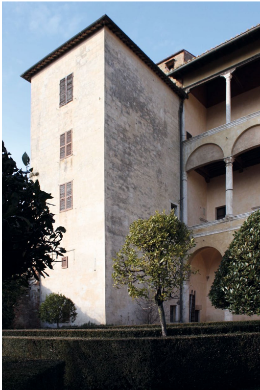
Abb. 202 Pienza, Palazzo Piccolomini, Gartenseite mit Küchen- trakt, Ansicht von Südosten, Sgraffito-Dekoration (restauriert, zum Teil rekonstruiert), Aufnahme 2015
