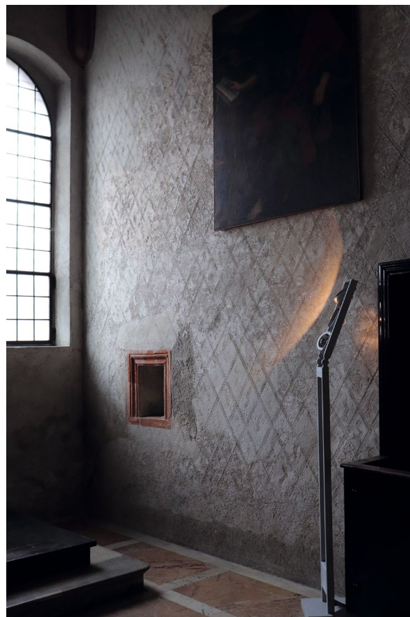
Abb. 228 Mailand, Santa Maria delle Grazie, Cappella San Pietro Martire, Ostwand, Sgraffito-Dekoration (restauriert), Aufnahme 2018
