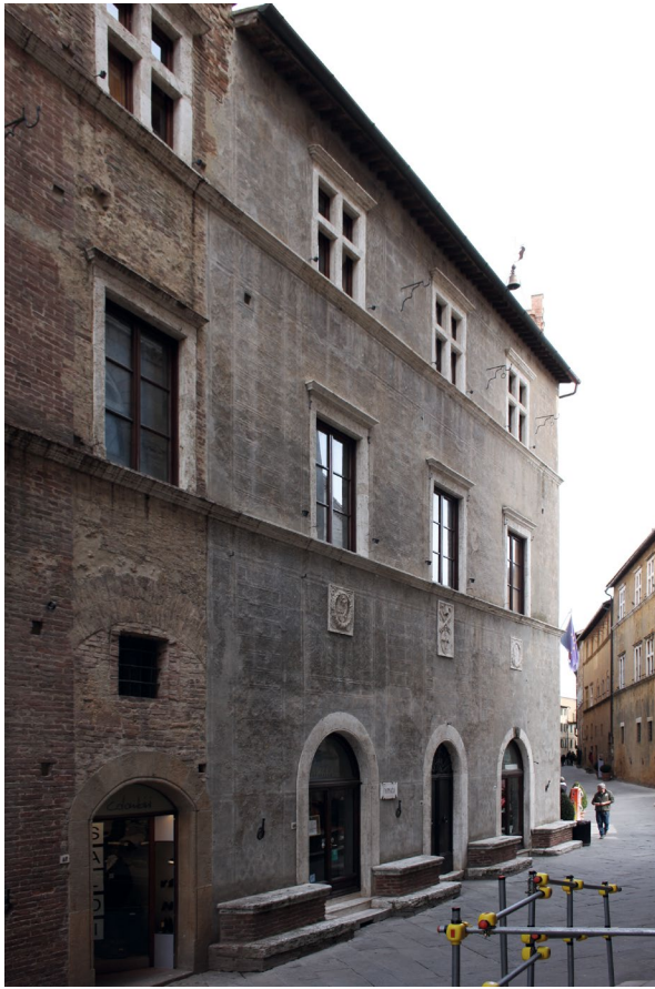
Abb. 206 Pienza, Palazzo Ammannati, Fassade zum Corso Rossellino, Sgraffito-Dekoration (restauriert), Aufnahme 2015
