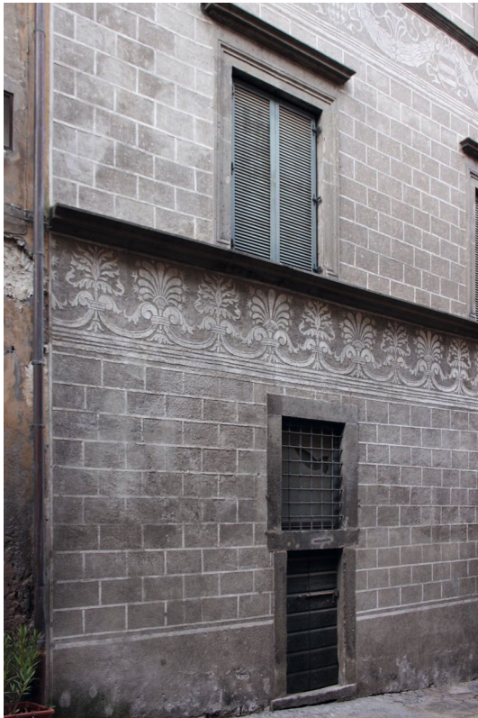
Abb. 217 Viterbo, Palazzo Calabresi, Fassade zur Via Calabresi, Erdgeschoss/1. Obergeschoss, Sgraffito-Dekoration (restauriert/rekonstruiert), Aufnahme 2015
