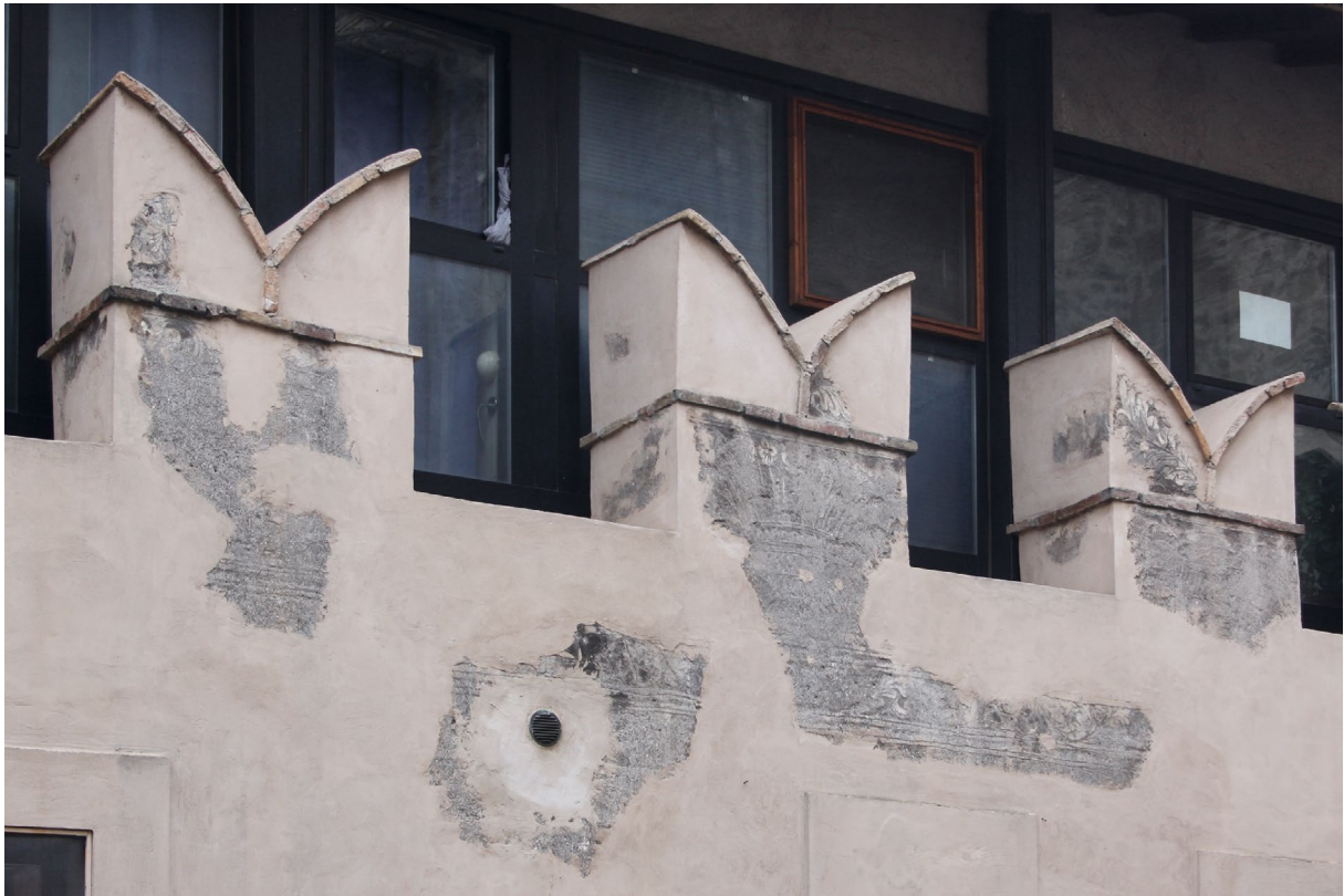
Abb. 215 Viterbo, Palazzo di Niccolò Perotti, Innenhof, Mauer mit Zinnen, Innenseite, Reste der Sgraffito-Dekoration, Aufnahme 2015
