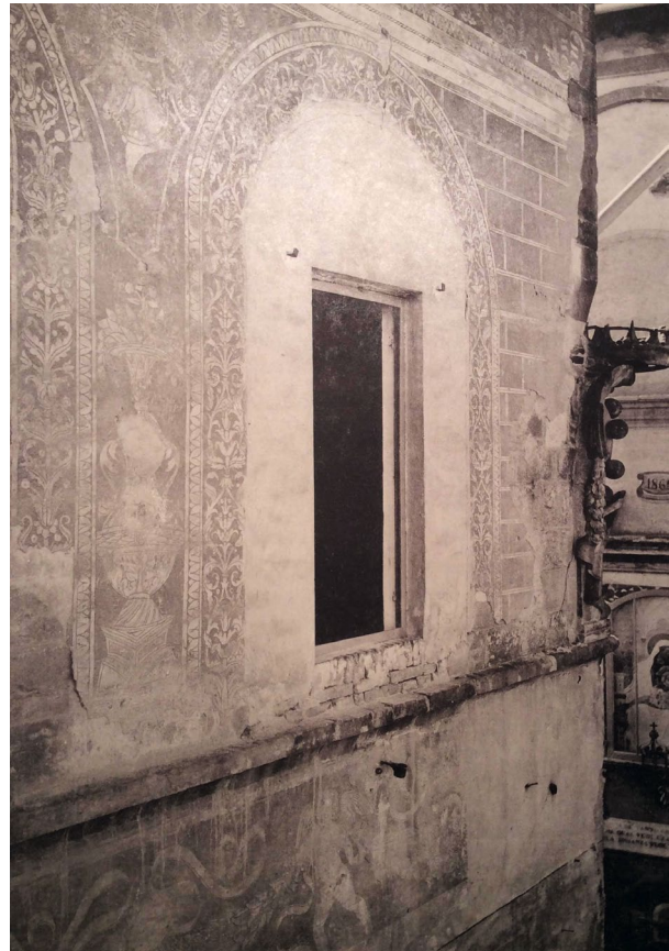
Abb. 191 Colle di Val d'Elsa, Palazzo del Comune, Fassade zur Via Gracca del Secco, Sgraffito-Dekoration, Aufnahme um 1900
