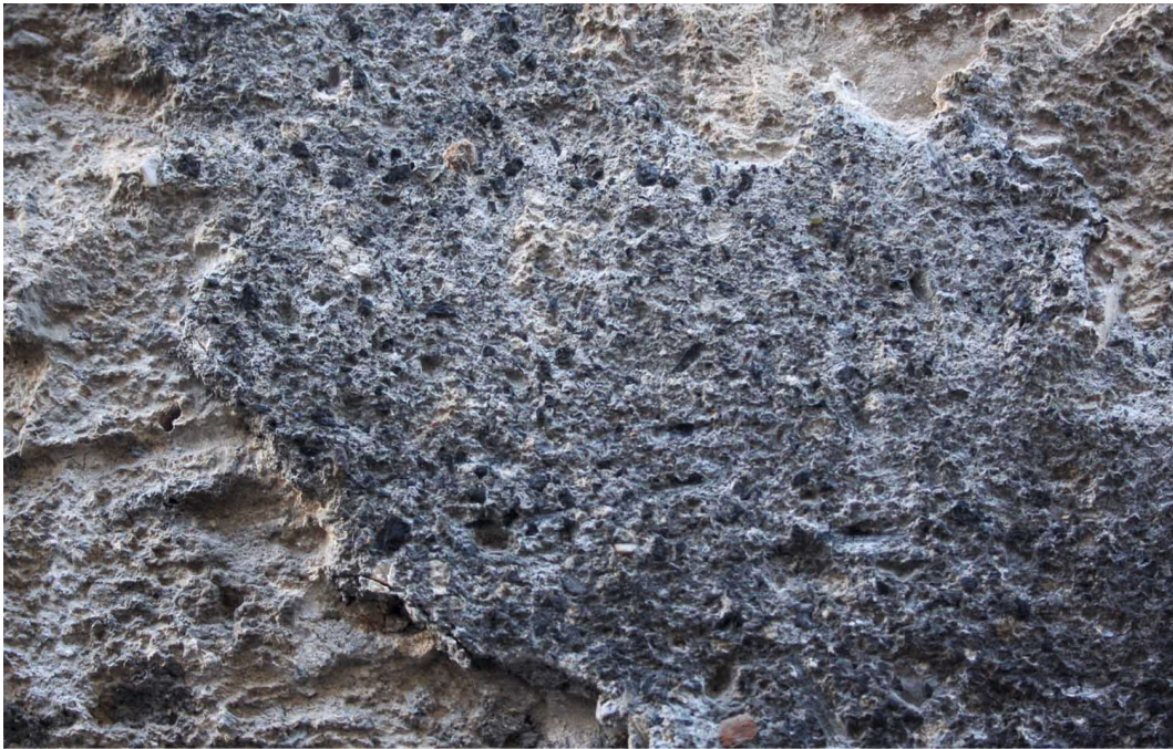
Abb. 220 Cagli, Palazzo Tirrani, Fassade zur Via Lapis, Sgraffito-Dekoration, gefärbter Mörtel mit Stücken des Schwarzpigments, Aufnahme 2016
