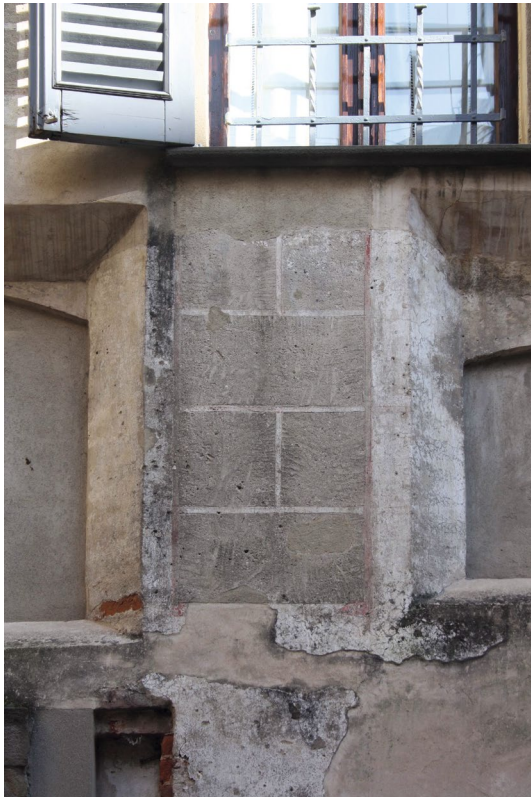
Abb. 234 Bergamo, Wohnhaus, Fassade zur Via Gaetano Donizetti 22, Mezzanin über dem Erdgeschoss, Sgraffito-Dekoration, Aufnahme 2017
