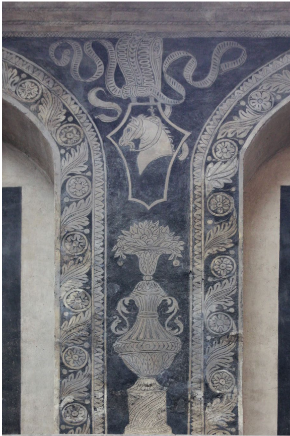
Abb. 190 Colle di Val d'Elsa, Palazzo del Comune, Fassade zur Via Gracca del Secco, 1. Obergeschoss, Sgraffito-Dekoration (restauriert, zum Teil rekonstruiert), Aufnahme 2015
