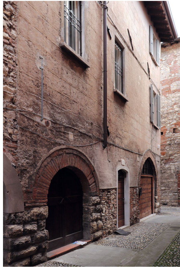
Abb. 236 Brescia, Casa del Moretto, Südseite, Sgraffito-Dekoration (restauriert), Aufnahme 2018
