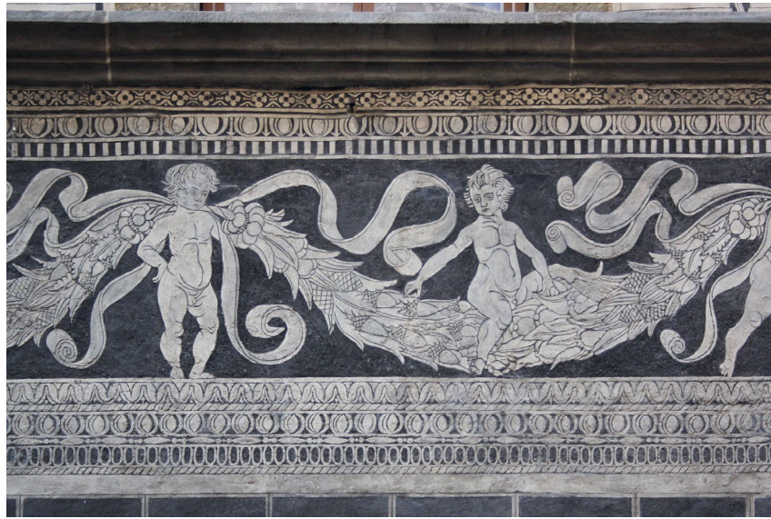
Abb. 161 Palazzo Nasi, Fassade zur Via San Niccolò, Erdgeschoss, Gebälk mit Sgraffito-Dekoration (restauriert) und Macigno -Gesims, Aufnahme 2012
