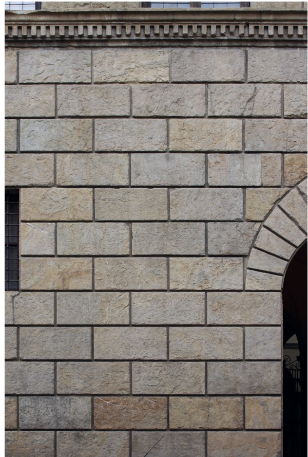
Abb. 172 Palazzo Boni-Antinori, Fassade zur Piazza Antinori, Verkleidung mit isodomem Quadermauerwerk, Aufnahme 2012
