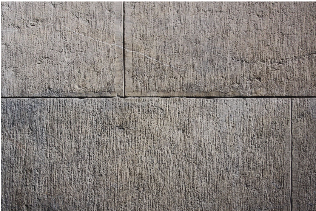
Abb. 169 Santa Croce, Querhaus, Pfeiler, Pietra forte -Quader mit Randschlag, Aufnahme 2012
