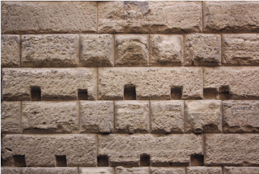
Abb. 174 Rom, Augustus-Forum, Außenmauer mit Bossen-Rustika, ca. 10 v. u. Z., Aufnahme 2013
