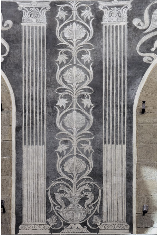
Abb. 159 Palazzo Nasi, Fassade zur Via San Niccolò, 1. Obergeschoss, Sgraffito-Pilaster, Aufnahme 2018
