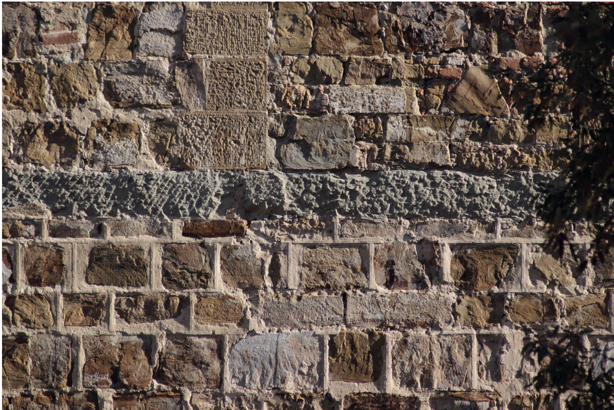
Abb. 156 Palazzo Da Uzzano, Fassade zur Via de' Bardi, 1./2. Obergeschoss, einfaches Quadermauerwerk mit Bandfugen, Aufnahme 2018
