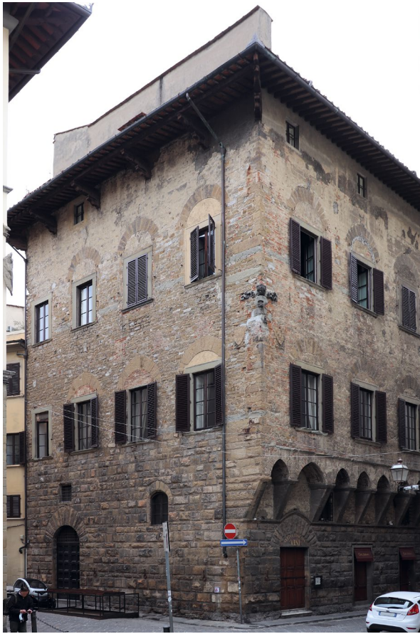
Abb. 182 Palazzo Benvenuti da Cintoia, Ansicht von Südost, Aufnahme 2014
