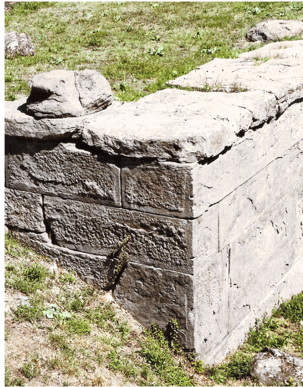
Abb. 173 Fiesole, römischer Tempel, 80 v. u. Z., Podium, Quadermauerwerk mit Randschlag, Macigno
