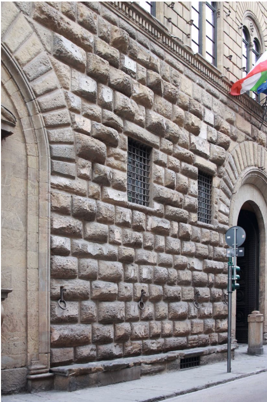
Abb. 157 Palazzo Medici, Fassade zur Via Cavour, Fassadengestaltung in Pietra forte , Aufnahme 2017
