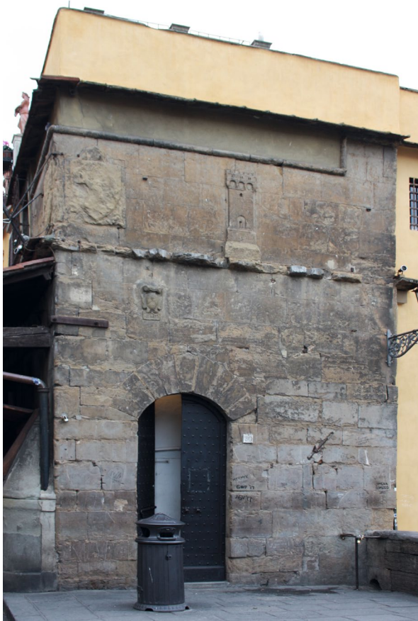
Abb. 178 Ponte Vecchio, Ladenbau der Ufficiali di Torre, Quadermauerwerk mit planer Oberfläche, Aufnahme 2017
