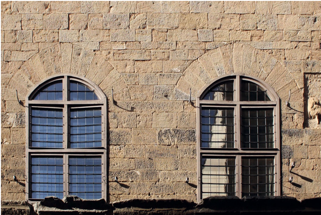
Abb. 168 Palazzo degli Alessandri, Borgo degli Albizzi, Quadermauerwerk mit planer Oberfläche, Aufnahme 2012
