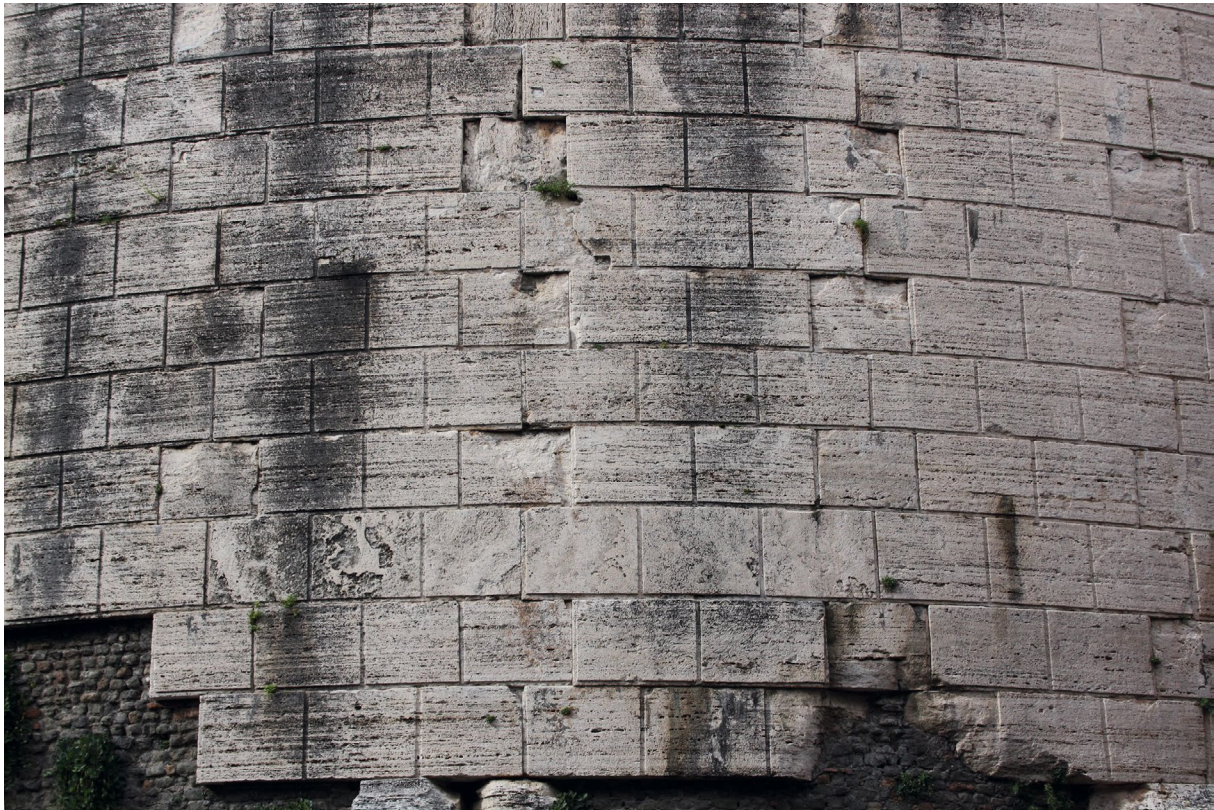
Abb. 170 Grabmal der Caecilia Metella, 30–10 v. u. Z., Außenseite mit isodomem Mauerwerk
