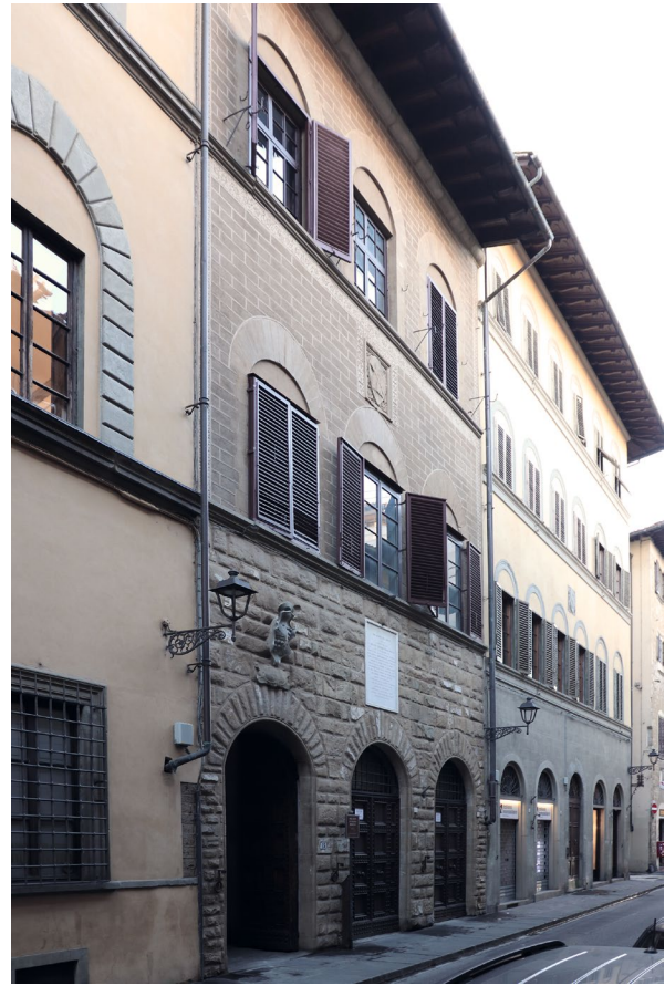
Abb. 183 Palazzo Corbinelli, Fassade zur Via Maggio, Aufnahme 2022
