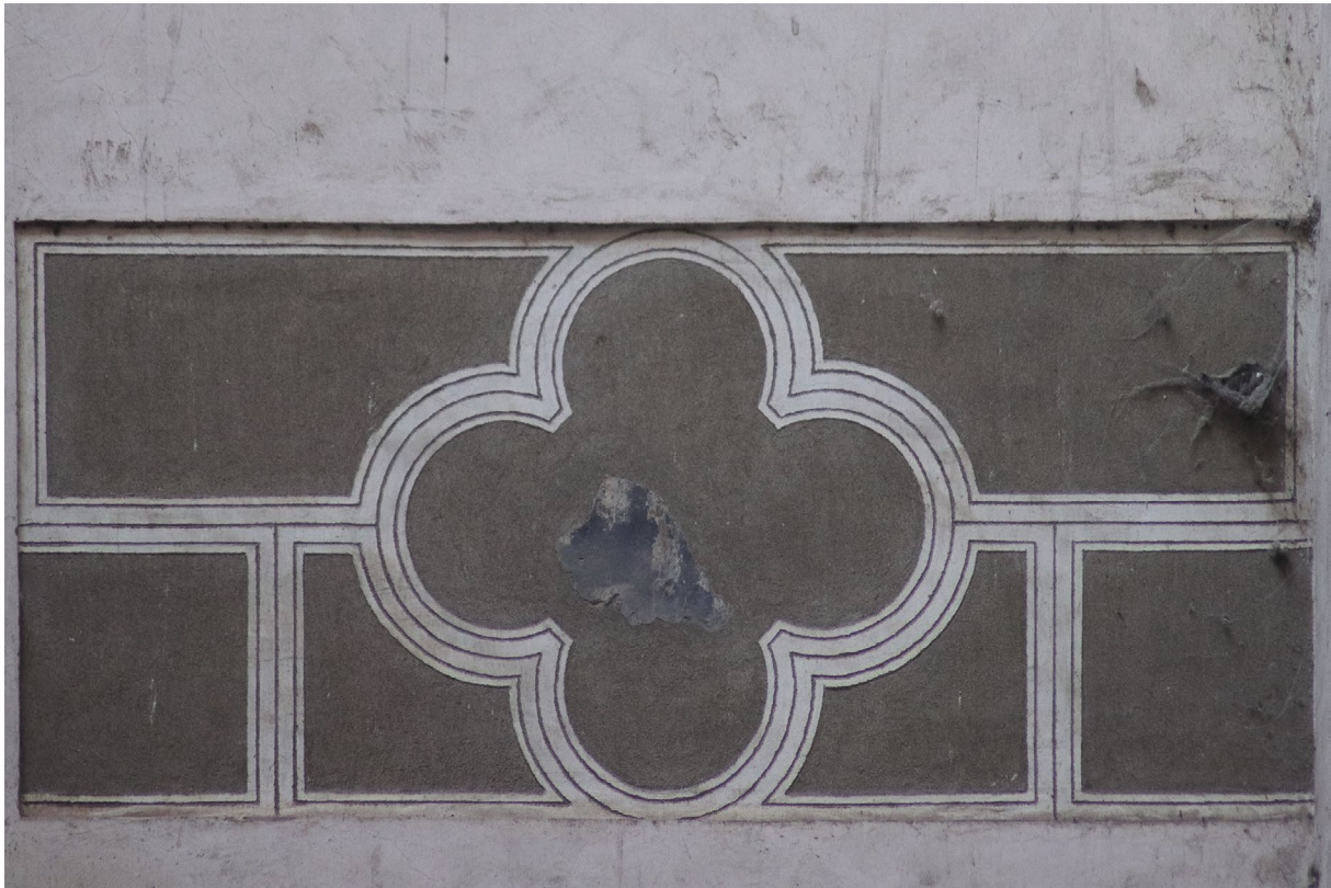
Abb. 120 Palazzo della Signoria, Innenhof, 1. Obergeschoss, Westseite, Befundfenster, Fragment der Sgraffito-Dekoration mit Resten einer goldenen Lilie (?), anschließende Wandgestaltung rekonstruiert, Aufnahme 2018
