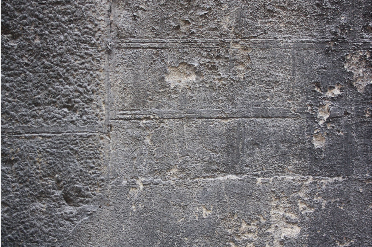
Abb. 124 Gebäude in der Via de' Bardi 15, Fassade, vermauerte Türöffnung, Sgraffito-Dekoration, Detail, Aufnahme 2017
