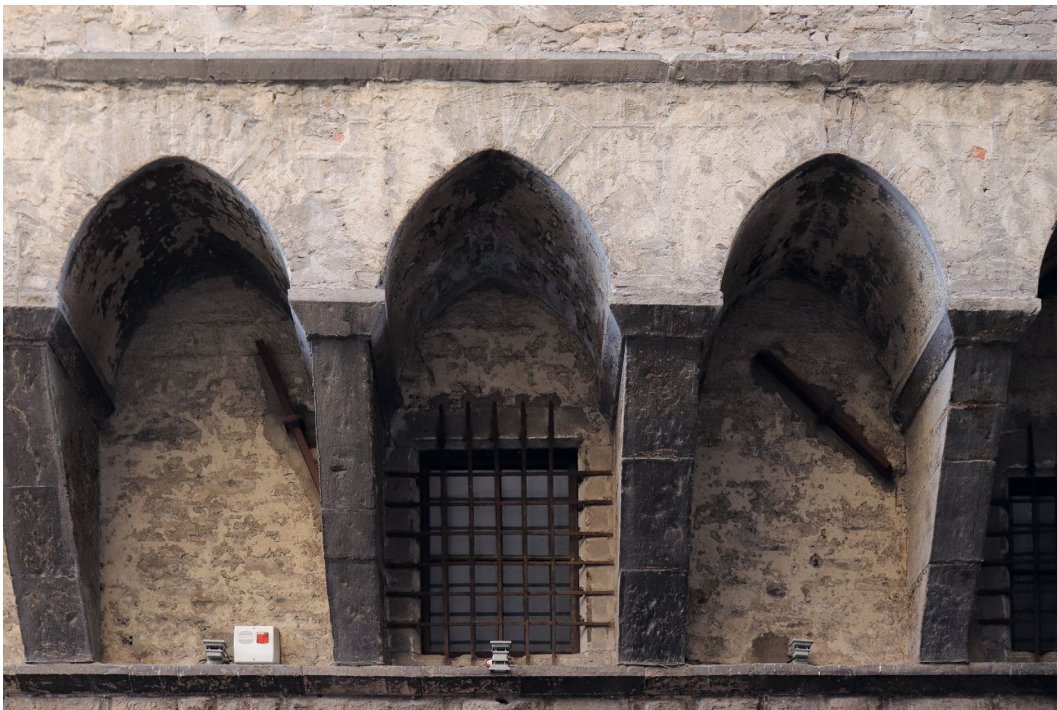
Abb. 126 Palazzo Benvenuti da Cintoia, Ost-Fassade, Bögen über den beccatelli mit Darstellung von Quadermauerwerk und Keilsteinen in Sgraffito, Aufnahme 2018
