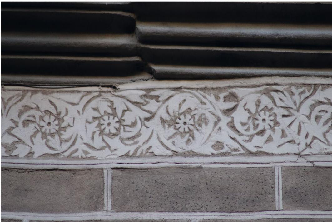
Abb. 113 Palazzo Corbinelli, Fassade zur Via Maggio, 1. Obergeschoss, Sgraffito-Dekoration (zum Teil rekonstruiert, restauriert), Fries unterhalb des *Macigno*-Gesimses, Aufnahme 2022
