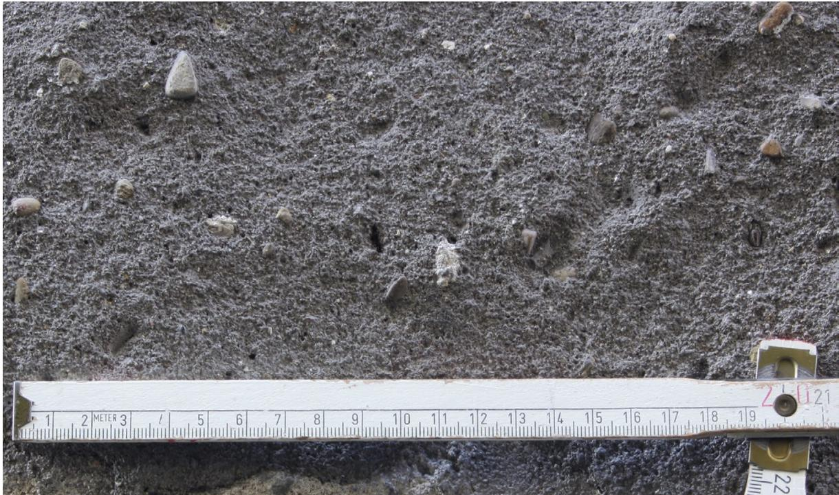
Abb. 110 Palazzo Spinelli, Fassade zum Borgo Santa Croce, Erdgeschoss, gefärbter Putz (möglicherweise nicht bauzeitlich) mit Kalkklumpen und Schwarzpigment, Aufnahme 2014
