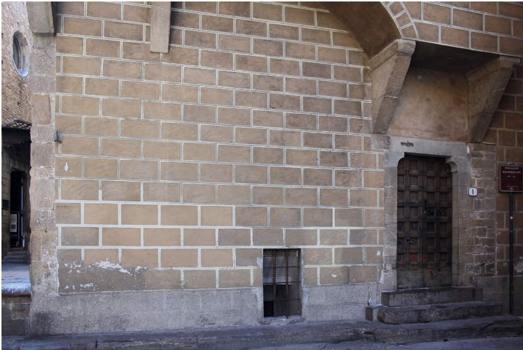
Abb. 53 Palazzo Giandonati, Fassade zum Vicolo del Panico, Erdgeschoss, Sgraffito-Dekoration (rekonstruiert, restauriert), Mörtel gelb-braun eingefärbt, Aufnahme 2015
