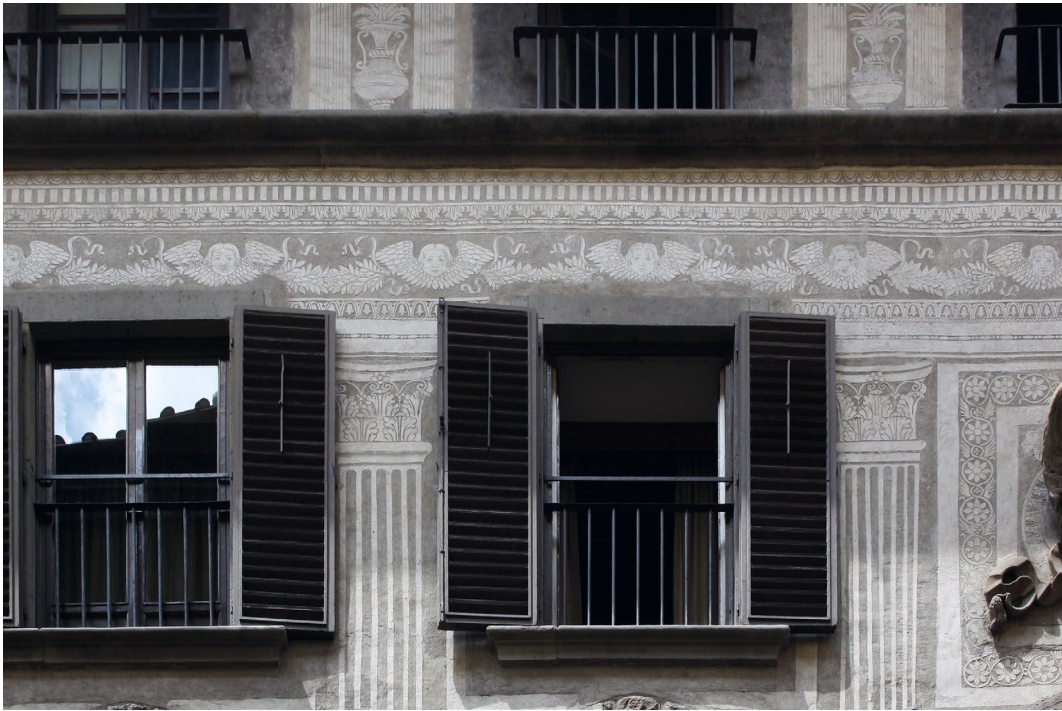
Abb. 76 Palazzo Dietisalvi Neroni, Fassade zur Via de' Ginori, 1. Obergeschoss, Sgraffito-Dekoration (restauriert), Aufnahme 2011
