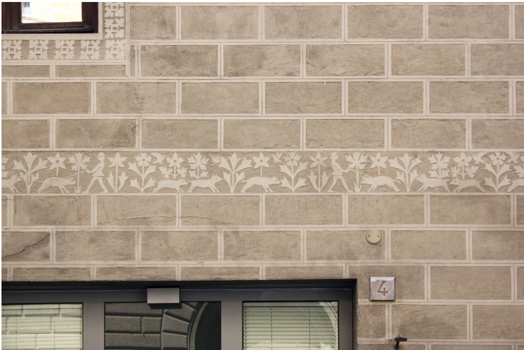
Abb. 54 Casa Davanzati, Fassade zur Piazza Davanzati, Erdgeschoss, Sgraffito-Dekoration (rekonstruiert, restauriert), Mörtel vermutlich ohne färbende Zusätze, Aufnahme 2011
