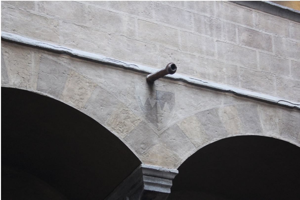
Abb. 55 Palazzo Davizzi, Innenhof, Südseite, 2. Obergeschoss, Brüstung des ballatoio und Bogen mit Sgraffito-Dekoration (restauriert, zum Teil rekonstruiert), Aufnahme 2015
