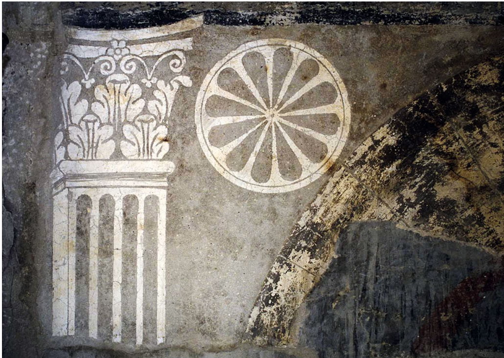
Abb. 78 Palazzo Dietisalvi Neroni, Fassade zur Via de' Ginori, 2. Obergeschoss, Sgraffito-Dekoration (während der Restaurierung), Pilaster, Aufnahme 2000
