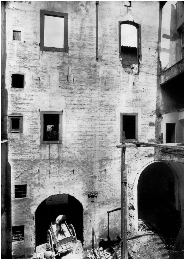
Abb. 84 Palazzo di Palla Novello degli Strozzi, Innenhof, Nordseite, Sgraffito-Dekoration, Aufnahme während des Abrisses 1893
