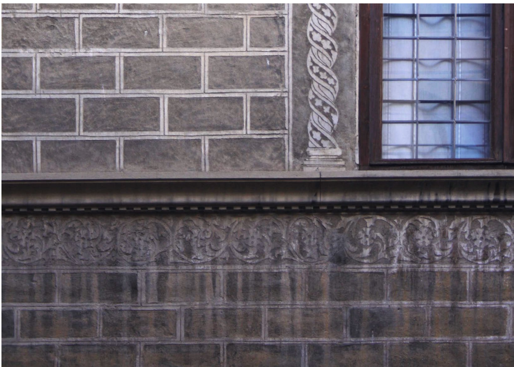
Abb. 67 Palazzo Da Fortuna/Palazzo Dietisalvi Neroni, Innenhof, Westseite, Erdgeschoss, Sgraffito-Dekoration mit Rankenfries (vermutlich rekonstruiert), Aufnahme 2015
