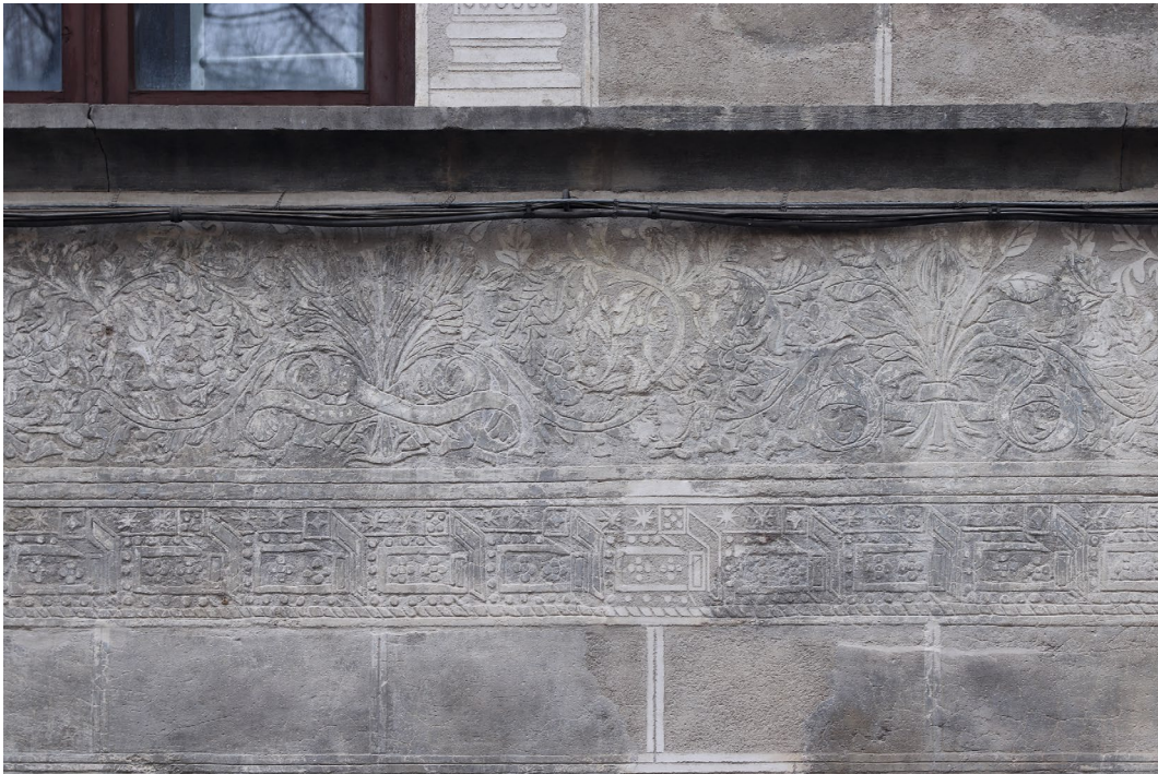
Abb. 74 Palazzo Lapi, Fassade zur Via Michelangelo Buonarroti, Erdgeschoss, Sgraffito-Dekoration (restauriert, zum Teil rekonstruiert), Gebälk mit Konsolen, Aufnahme 2018
