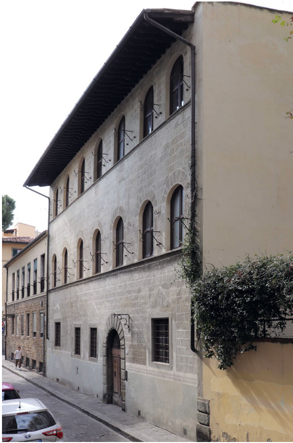
Abb. 8 Palazzo Lapi, Fassade zur Via Michelangelo Buonarroti, Aufnahme 2020
