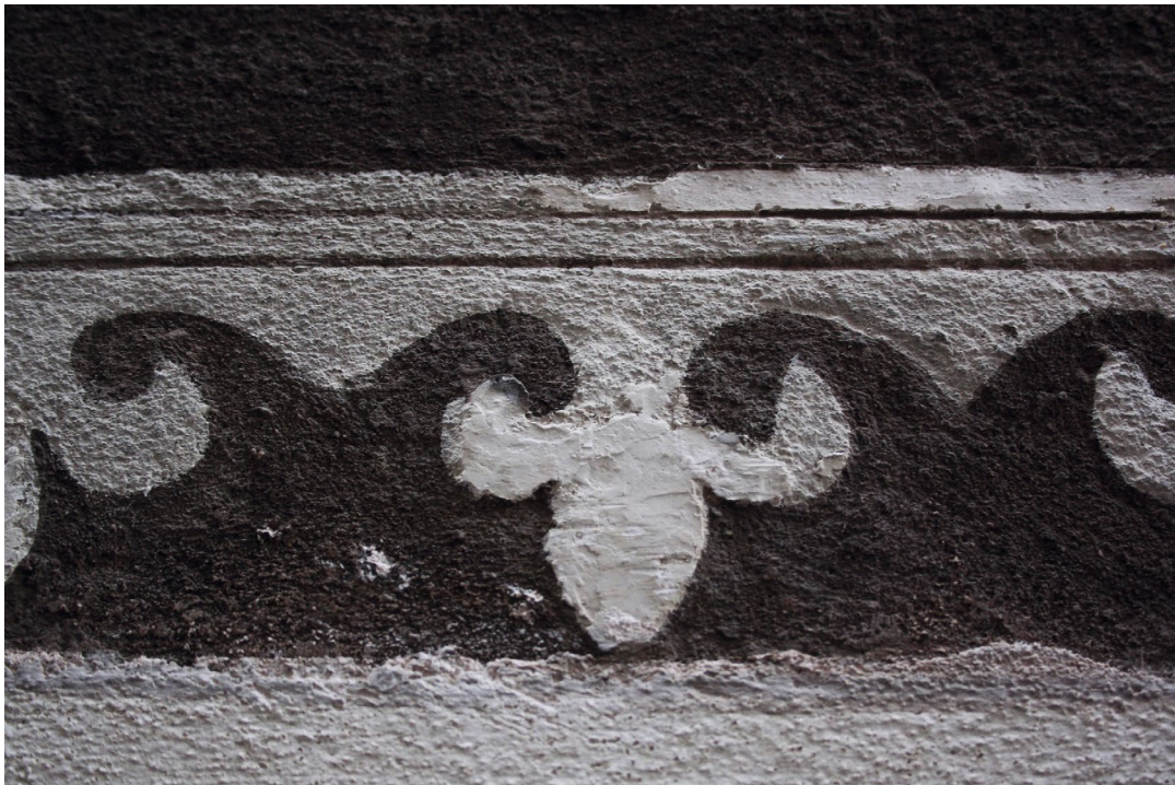
Abb. 30 Palazzo Corsi, Fassade zum Borgo Santa Croce, Sgraffito-Dekoration (rekonstruiert, restauriert), Sockelabschluss mit nachgemalter Ornamentik, Aufnahme 2017
