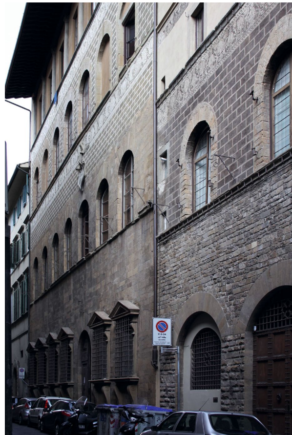
Abb. 23 Palazzo Valori (Galli-Tassi) und Palazzo Rittafé, Fassaden zur Via de' Pandolfini, Sgraffito-Dekorationen des 19. Jahrhunderts, Aufnahme 2011
