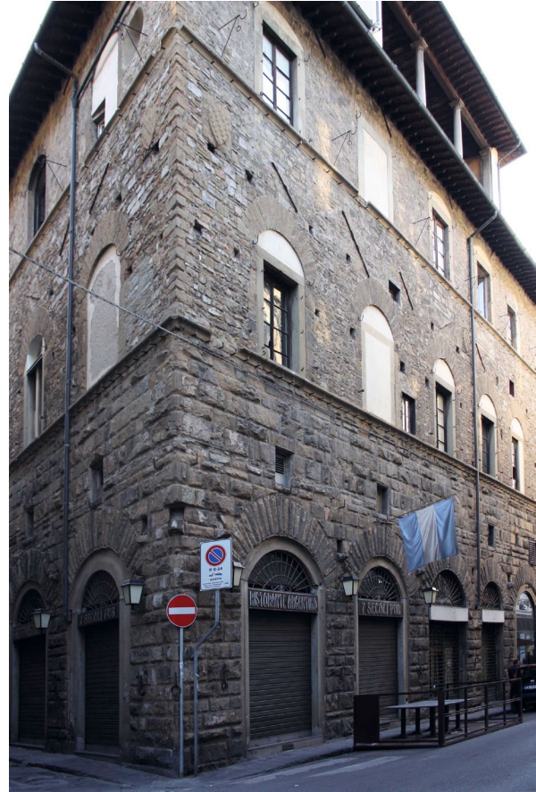
Abb. 18 Palazzo Salviati, Ansicht von Südwest, Fassade mit freigelegtem Mauerwerk, Aufnahme 2014
