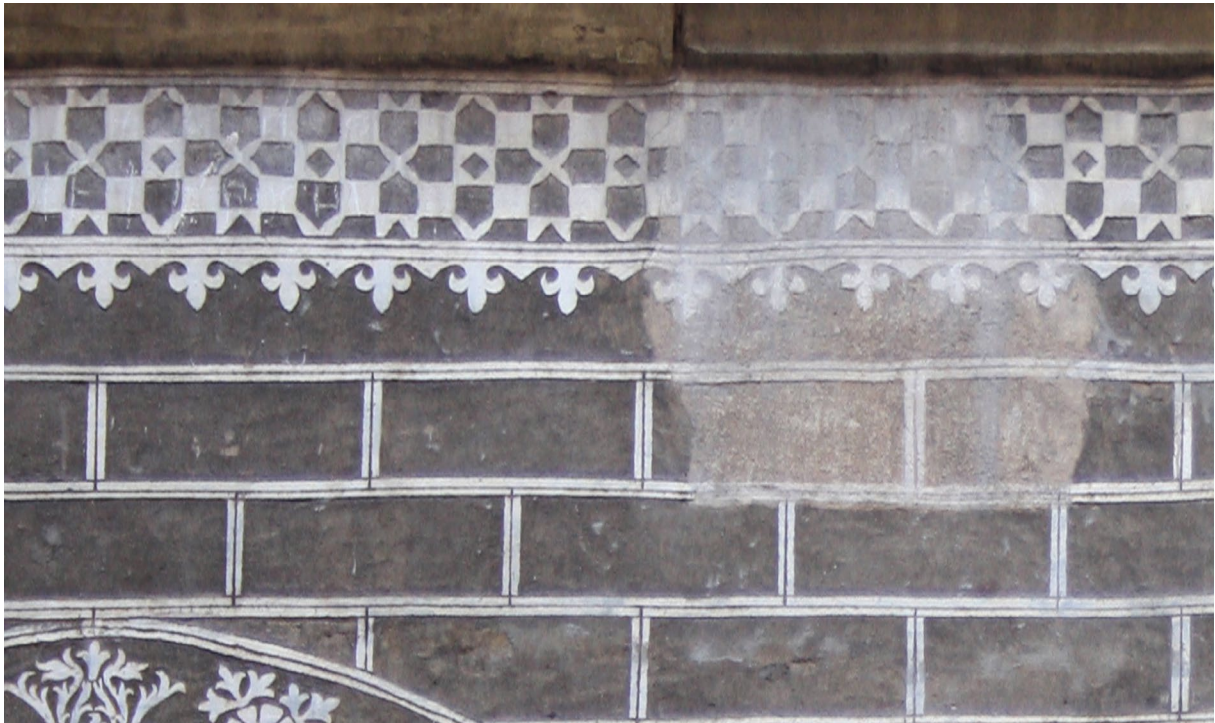
Abb. 7 Palazzo Corsi, Fassade, 1. Obergeschoss, Detail der Sgraffito-Dekoration (überwiegend rekonstruiert, Fragmente der Quattrocento-Gestaltung integriert), Aufnahme 2016
