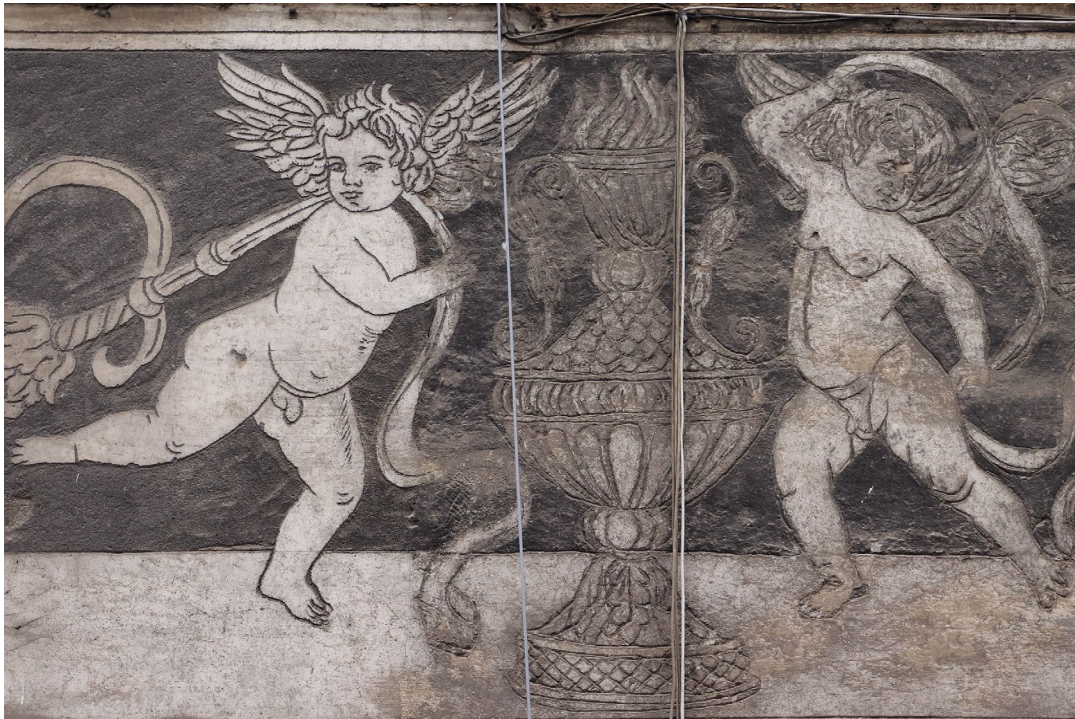
Abb. 29 Palazzo Capponi, Fassade zur Via Coverelli, 1. Obergeschoss, Sgraffito-Dekoration mit putti reggifestoni und Flammenvase (Putten überwiegend rekonstruiert, Flammenvase restauriert), Aufnahme 2019
