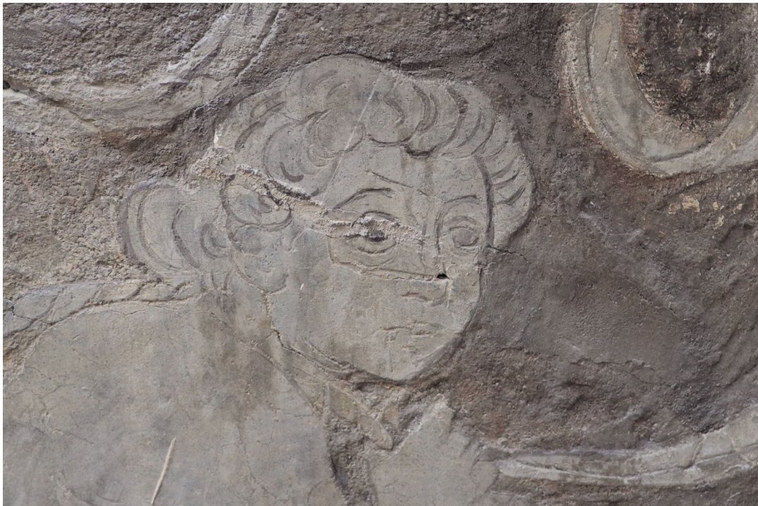
Abb. 28 Palazzo Vecchietti, Innenhof, Ostseite, 1. Obergeschoss, ballatoio , Brüstung mit Sgraffito-Dekoration (restauriert, stark überfasst), Aufnahme 2018
