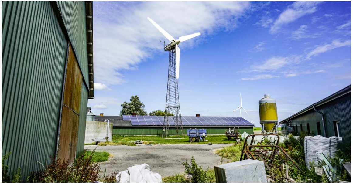
Abb. 3: Vestas V15 (Bj. 1983) von Karl-Heinz Hansen in Nordfriesland als Symbol des Aufschwungs der Windenergienutzung in Deutschland (2020)
