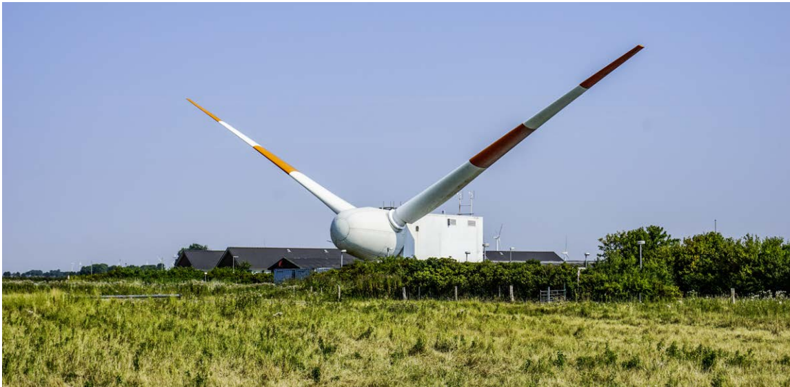
Abb. 2: Maschinenhaus der MAN WKA 60 (Baujahr 1991) auf Growian-Fundament als Symbol der gescheiterten Großanlagenentwicklung (2020)
