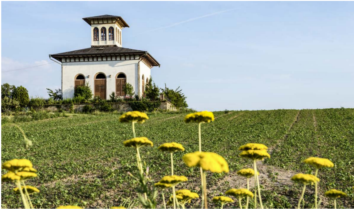
Abb. 1: Das Ruppertsberger Teehaus im Jahr vor dem großen Brand und vor der Neubepflanzung des Weinbergs – dank der Tatsache, dass die halbrunden, gusseisernen Oberlichter in Vorbereitung einer Instandsetzung bereits ausgebaut waren, entgingen sie später der Feuersbrunst (09.07.2013)
