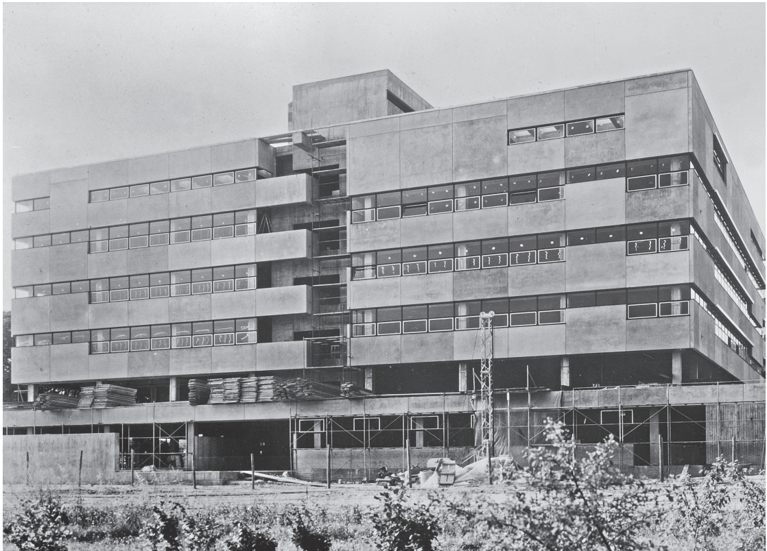
Abbildung 13 Architekturgebäude der TU Darmstadt im Bau, ca. 1968, Foto: Unbekannt, Glasdia-Sammlung Fachgebiet Architektur- und Kunstgeschichte, TU Darmstadt.
