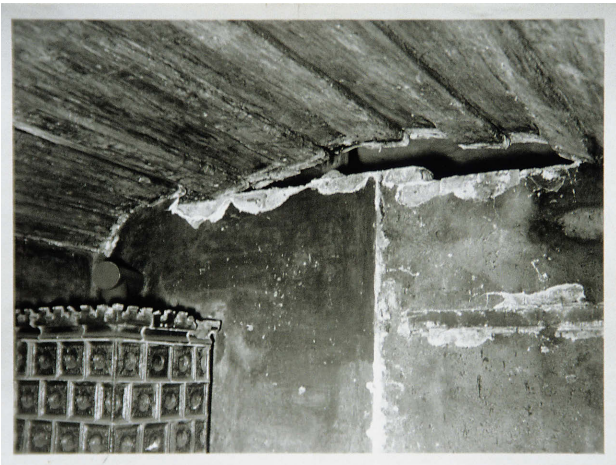
18 Nürnberg, Kartäuserkloster. Foto einer Mönchszelle mit gewölbter (spätgotischer) Bohlen-Balkendecke vor der Zerstörung (Foto wohl 1956).
