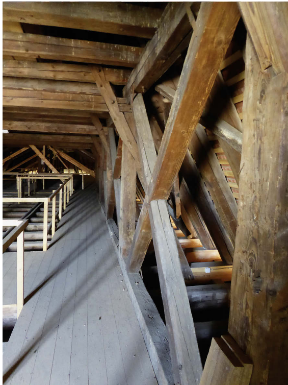
4 Nürnberg, Kartäuserkloster, Kirche, Dachwerk. Stehender Stuhl mit angeblatteten Sparrenstreben; das stabilisierende Andreaskreuz vorne entstand nach 1945 (Foto 2018).
