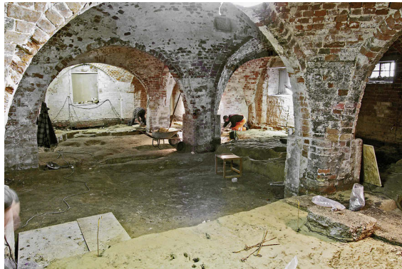
9 Kleine Burgstraße 22 (Kranenkonvent). Der Keller überwölbt mit neun Hängekuppeln.
