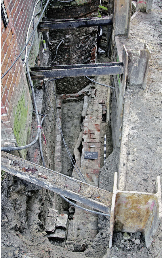
8 St.-Annen-Straße 13. Die Südwestwand des Kellers unter Haus 4. In der Mitte, nördlich der Wand, ist der zweite Ansatz eines Gewölbegurts zu erkennen.
