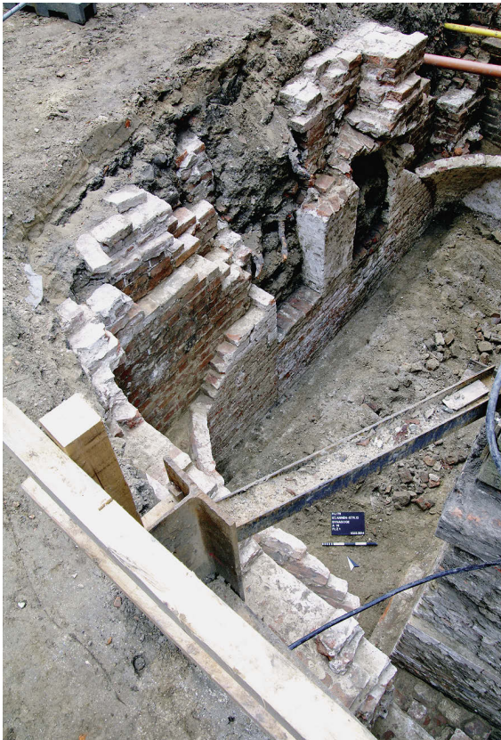
6 St.-Annen-Straße 13. Keller in Haus 4. Blick auf die Nordwestwand mit zwei Kellerfenstern. Unten links und oben rechts sind die Reste einer hängenden Gewölbekuppel sichtbar.
