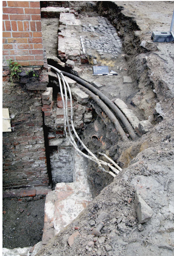
5 St.-Annen-Straße 13. Nordwestwand des Kellers unter Haus 3. Seitlich liegt das neuzeitliche Pflaster mit integrierter Wasserrinne, vorne die Wandnische.
