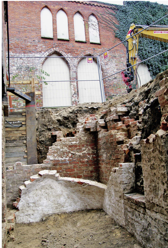
7 St.-Annen-Straße 13. Reste des hängenden Kuppelgewölbes in der Westecke des Kellers in Haus 4. Im Hintergrund die Kirchenwand des St. Annenklusters.
