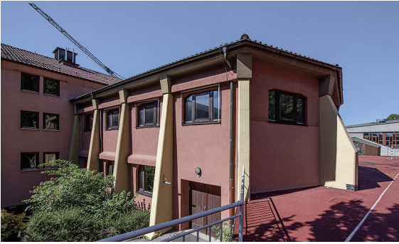
6 Erster Schulbau, 1921/22 und 1952, Annexbau auf der Rückseite. Ansicht von Süden (2020).
