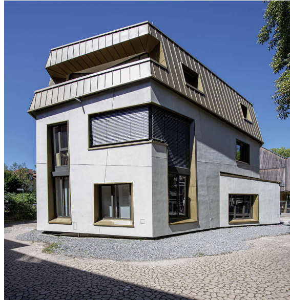
20 Verwaltungsbau, 2019. Ansicht von Nordosten (2020).
