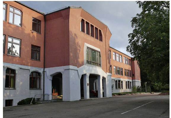
5 Erster Schulbau, 1921/22 und 1952, Hauptfassade. Ansicht von Nordwesten (2019).
