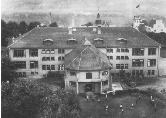
4 Erster Schulbau, 1921/22 und 1952, Annexbau auf der Rückseite (Turnhalle/Festsaal). Ansicht von Süden (um 1922).
