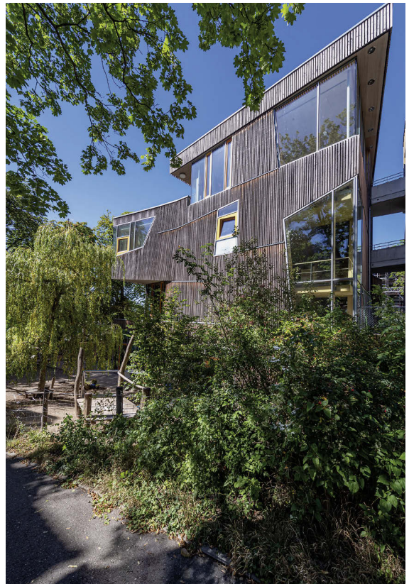
17 Hort- und Mensagebäude, 2005–07, Nord-Fassade (2020).
