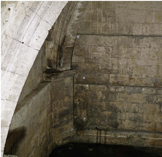
7 Unterkirche, Fluchtkorrekturen am Innenhaupt der West- und Nordwand (2010).
