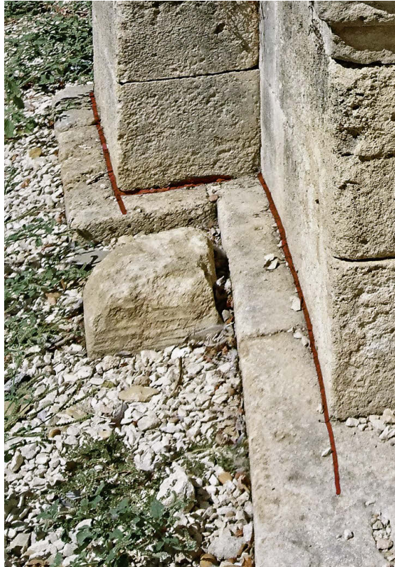
11 Chorumgang, in die Fundamentoberkante eingravierte Ritzzeichnung des Chorgrundrisses (rote Markierung) (2017).
