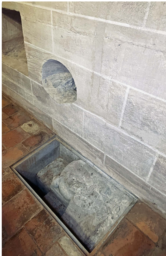
19 Wandnische und ehemalige Piscina in der Ostwand des „Vestibulums“ mit der im heutigen Boden versunkenen Basis der südöstlichen Ecksäule und Resten der ehemaligen Südmauer.
