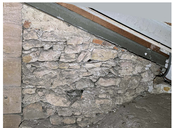
14 Ostwand des Dachraums: Quaderecke des Chorstrebpfeilers, gegengesetzte Bruchsteinmauer und ganz rechts Beginn des Vorsprungs.
