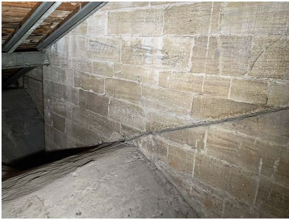
11 Nördlicher Teil der Westwand mit nach Süden absinkender Kerbe. Im Hintergrund das Quadermauerwerk des Querhaus-Strebepfeilers.
