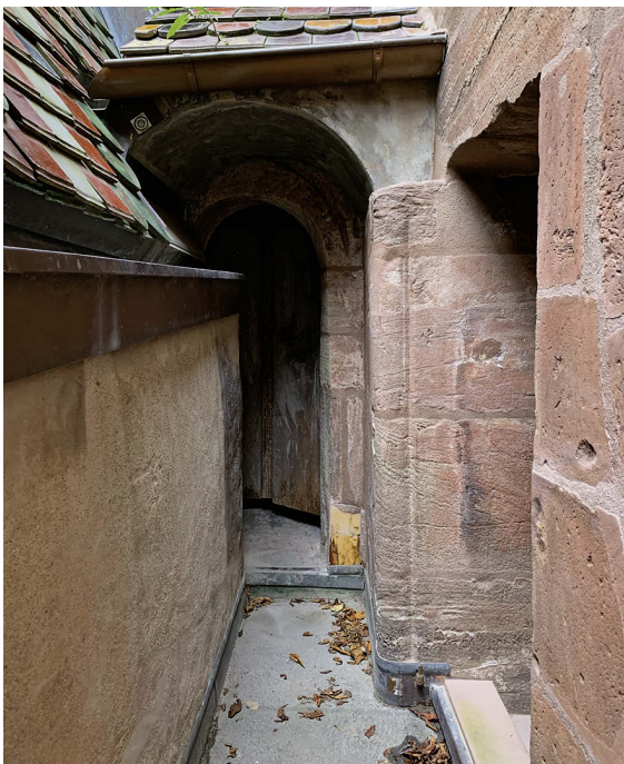
2 Rundbogige Tür, die von der „Chorgalerie“ zum Dachraum führt, rechts die Tür zur Chorempore.
