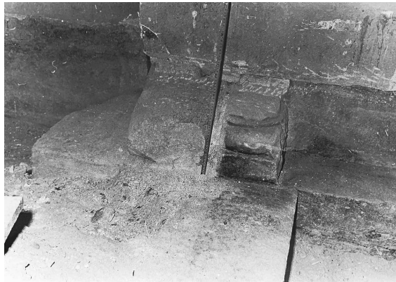
18 Die Basis der südwestlichen Ecksäule auf einer Sockelbank und links davon der Rest der älteren Südmauer (Freilegung 1967). Das heutige Bodenniveau des „Vestibulums“ auf Höhe der horizontalen Putzkante oberhalb des Säulenrestes.
