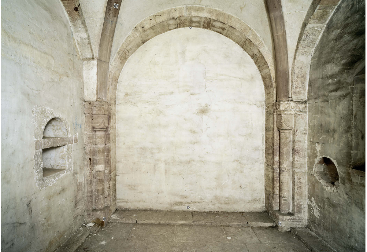
24 Das zweite Geschoss der „Alten Sakristei“ nördlich des Chores. Kreuzrippengewölbe auf Ecksäulchen, Wandnische (links) und ehemalige Piscina in der nördlichen Außenwand (rechts).
