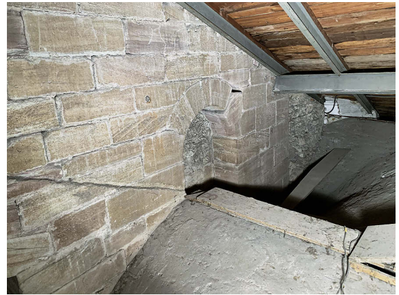
12 Ostwand des Dachraums mit Fensternische und nach Süden abfallender Kerbe.
