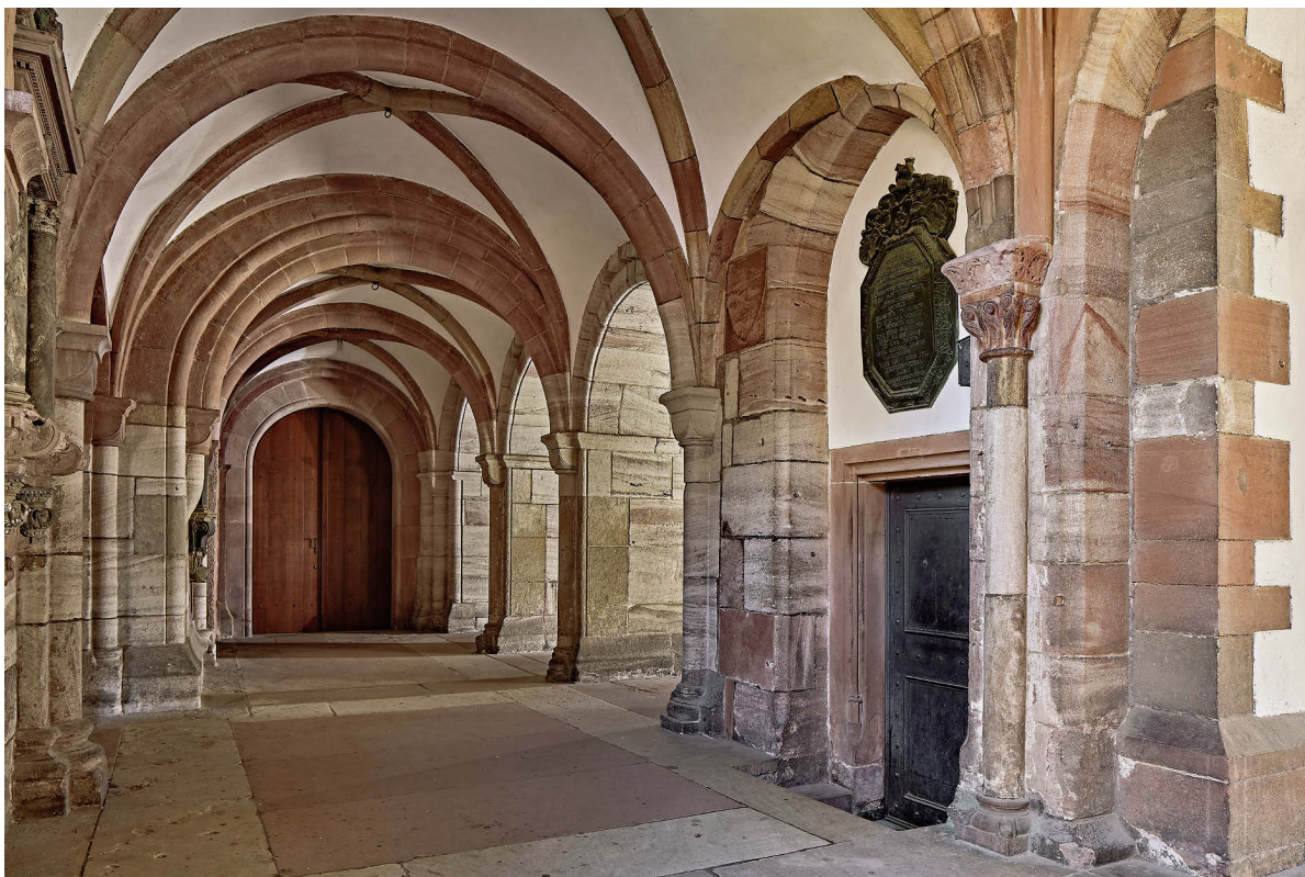
20 Die vier erhaltenen romanischen Joche des Kreuzgangs, im Hintergrund die „Kanonikertür“ zum Chorumgang, rechts die Dreierarkade und vorne die Tür der Wendeltreppe zum Münstersaal.
