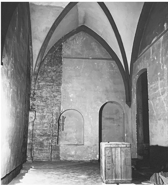
15 „Vestibulum“ nach Süden mit Maßwerkfenster und Piscina zum Kreuzganghof, rechts vorne Querhausecke mit dem Ansatz einer ehemaligen Mauer und eines niedrigeren Gewölbes. Rechts hinten der Strebpfeiler des Querhauses mit Durchgang zur „Neuen Sakristei“. Links hinten die vorspringende Ecke des Münstersaalbaus.
