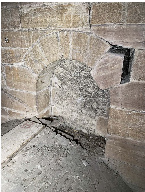
14 Ostwand des Dachraums: Quaderecke des Chorstrebpfeilers, gegengesetzte Bruchsteinmauer und ganz rechts Beginn des Vorsprungs.
