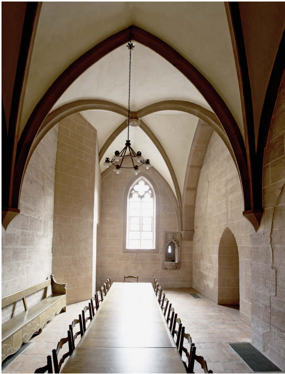
15 „Vestibulum“ nach Süden mit Maßwerkfenster und Piscina zum Kreuzganghof, rechts vorne Querhausecke mit dem Ansatz einer ehemaligen Mauer und eines niedrigeren Gewölbes. Rechts hinten der Strebpfeiler des Querhauses mit Durchgang zur „Neuen Sakristei“. Links hinten die vorspringende Ecke des Münstersaalbaus.
