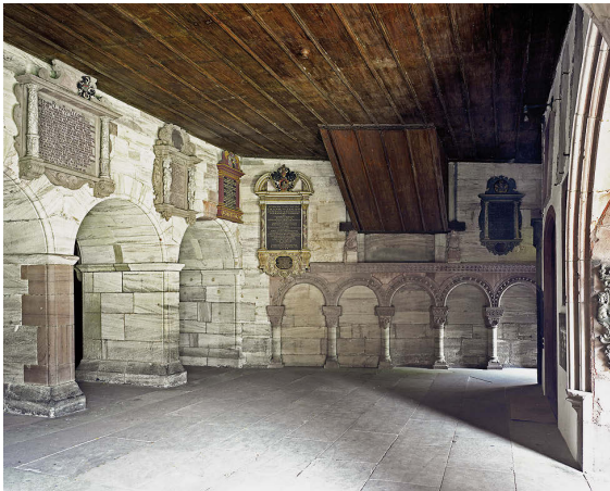
22 Die Dreierarkade (links), auf der der Chorstrebe Pfeiler ruht, und die Außenwand des Chores. Zwischen Dreierarkade und Blendarkade des Chorssockels liegt ein 0,5 m breiter Wandstreifen. Das ehemalige Fenster oberhalb der Blendbögen wurde später zu einem Zugang zum Münstersaal im Obergeschoss umgebaut (Schräge in der Decke).
