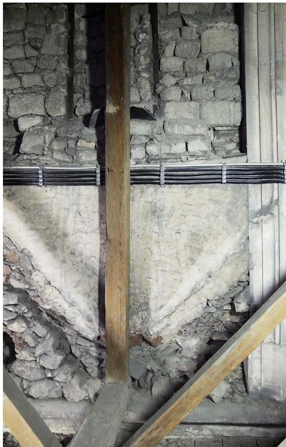
13 Detailaufnahme vom Dachstuhl der Sakristei. Der Deckenbalken liegt auf der Solbank der bauzeitlichen Südfassade. Für den Anbau der Sakristei musste ein Fenster der Südfassade der Kirche zugemauert werden.
