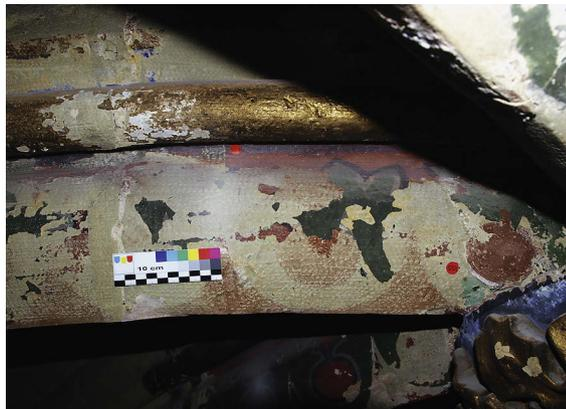
4 Detailaufnahme mit der bemalten Schlusssteinmanschette in der nordöstlichen Doppelkapelle; darüber befindet sich fragmentarisch noch die Rekonstruktionsfassung von 1864/65.
