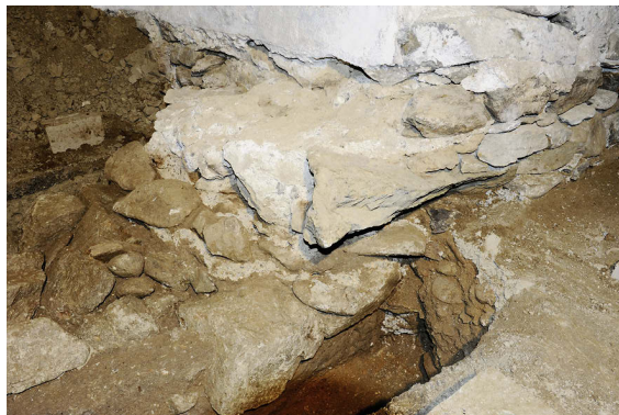
6 Detail von Abb. 5 gegen Südwesten. Weiß ist die Westlaibung der Südapsis, darunter die Verzahnung des jüngeren Schifffundaments mit dem kleinsteinigen und ungemörtelten Vorgängerbau F609 (Mörtelspritzer von modernen Baumaßnahmen).
