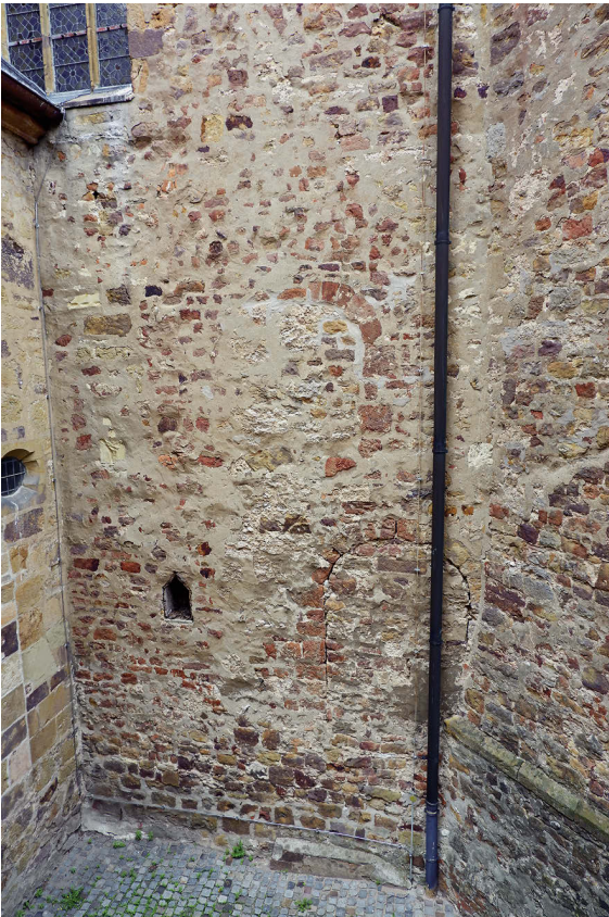
7 Südmauer der Klosterkirchenapsis vom barocken Nordtrakt der Klausur gesehen. Gut zu erkennen ist die zugemauerte Tür mit Rundbögen, daneben eine kleine offene Nische, darüber nach Westen versetzt ein zugemauertes Rundbogenfenster. In dem sich nach Westen anschließenden Anbau sind zwei weitere Rundbogenfenster im Dach- und darunterliegenden Geschoss erhalten.
