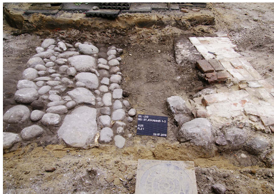
17 Strebepfeiler der nördlichen Kreuzganginnenmauer, Blick nach Westen. Südlich des Strebepfeilers verläuft ein Weg aus Findlingen mit seitlicher Rinne in West-Ost-Richtung über den Kreuzhof.
