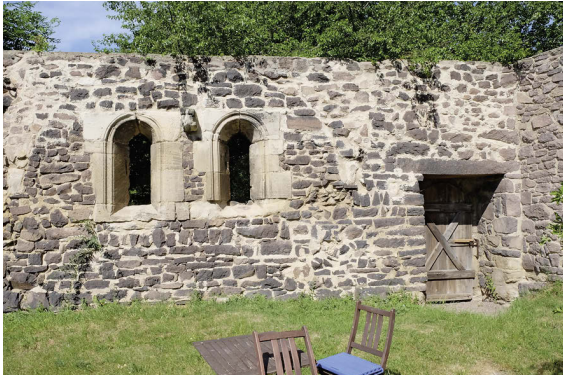
5 Westliche Klausurwand mit Durchgang, Blick aus ehemaligem Kreuzgang (Foto 2015).
