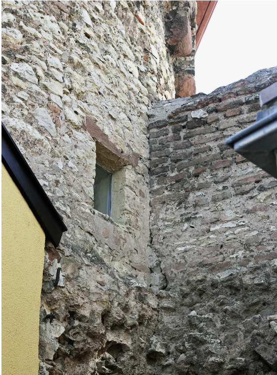
20 Ostansicht der Stadtmauer am Lenhardturm mit dem Ansatz einer abgebrochenen Arkade und darunterliegenden Balkenlöchern (Foto 2018).
