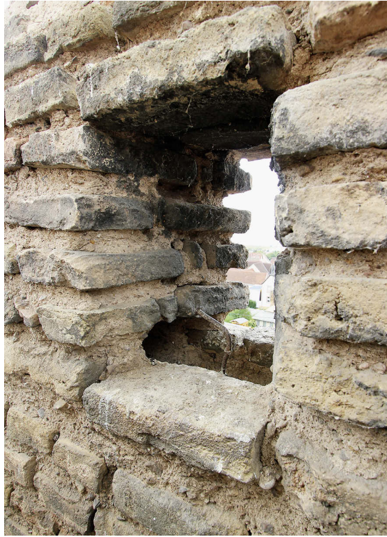
13 Scharte in der südlichen Zinne mit Auflager eines ehemaligen Ringankers. Darunter eine doppelte Lagerfuge (Foto 2018).
