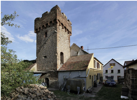
3 Der Johannisturm von Nordwesten (Foto 2018).
