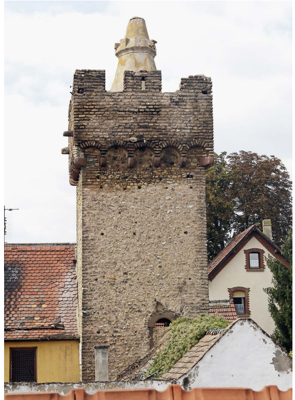
12 Ostansicht des Johannisturms (Foto 2018).
