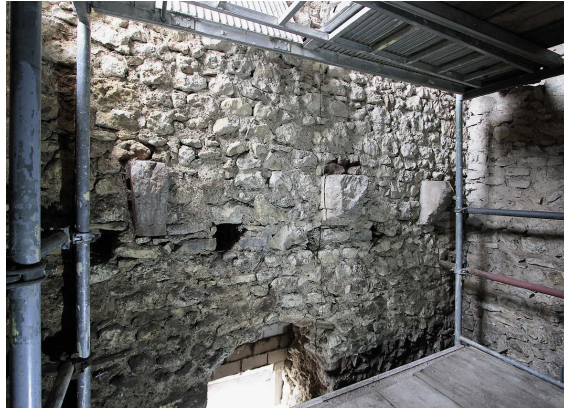
16 Turminneres Richtung Nordosten mit drei Konsolsteinen der Nordwand als Auflager eines zunächst geplanten Wehrgangs (Foto 2018).
