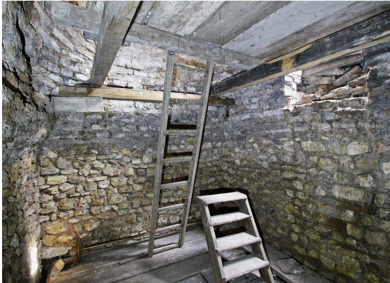
14 Turminneres unterhalb der auskragenden Wehrplattform. Unterhalb der provisorisch eingefügten Decke drei Reihen originaler Backsteine als Ansatz eines pyramidenförmigen Dachaufsatzes, darüber Mauerwerk des 19. Jahrhunderts (Foto 2018).
