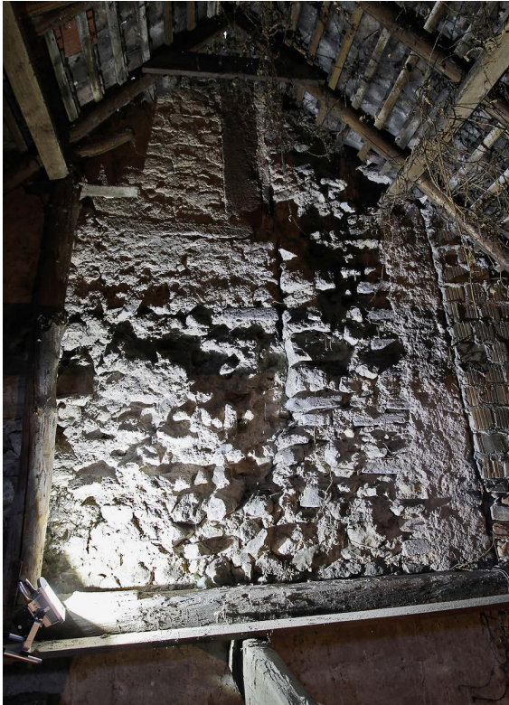
11 Ostansicht des Johannisturms im Bereich der vorgebauten Scheune im Streiflicht. Rechts im Bild die aus der Mauerflucht vorstehende Nordostecke des Turms; rechts vom Sandsteingewände mit vertikaler Fuge darunter die Ausbruchstelle der ehemaligen Stadtmauer; unterhalb des vermauerten Durchgangs weitere Ausbruchstelle einer mutmaßlichen Arkade (Foto 2018).
