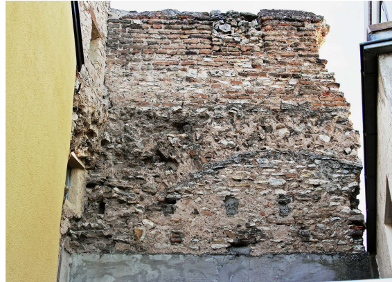
20 Ostansicht der Stadtmauer am Lenhardturm mit dem Ansatz einer abgebrochenen Arkade und darunterliegenden Balkenlöchern (Foto 2018).
