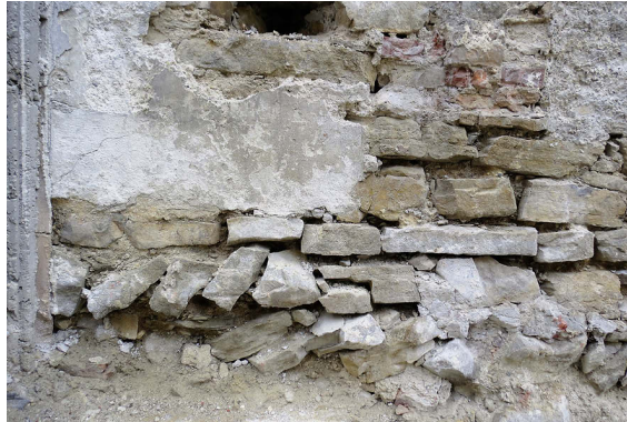
1 Wien, Renngasse 10. Mauerwerk des Kernbaus um 1200.
