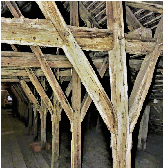
5 Schwarzach, St. Peter und Paul, Hochschiffdach. Aufreihung von Hängeträgern in Form von Gespärren.
