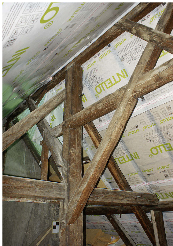
28 Basel, Petersgraben 5. Kombination von Hängebund und Längsbund zum Hängewerk, Ausschnitt, 1365 d.
