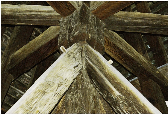
30 Lausanne, Kathedrale, Nordturm. Abstrebung des Hängeholzes, 1252 d.
