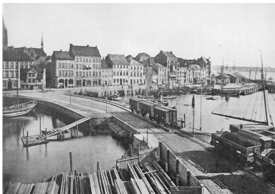
4 Eisenbahndamm am Bootshafen (um 1880).
