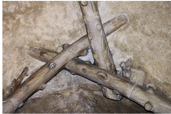
12 Wladislaw-Oratorium, „Triangelknoten“ der Emporenunterwölbung (Foto 2016).
