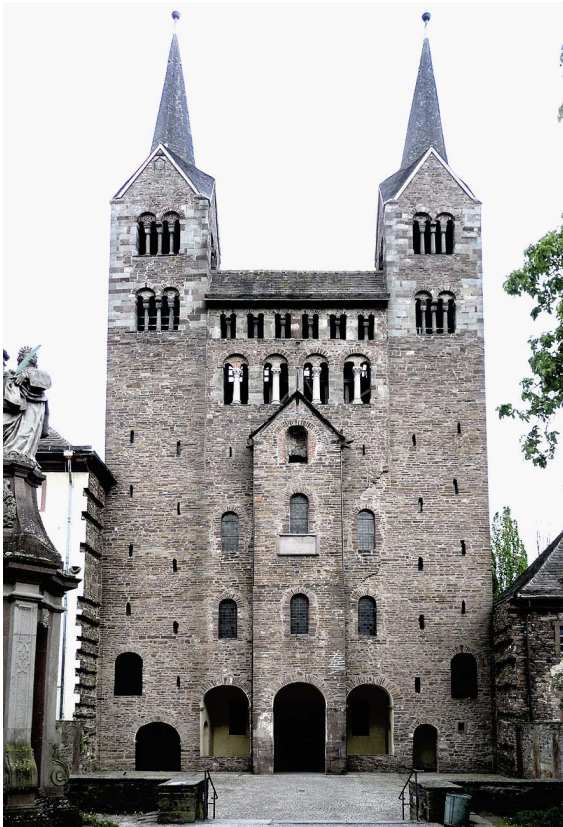
1 Corvey, Westbau der Klosterkirche von Westen.
