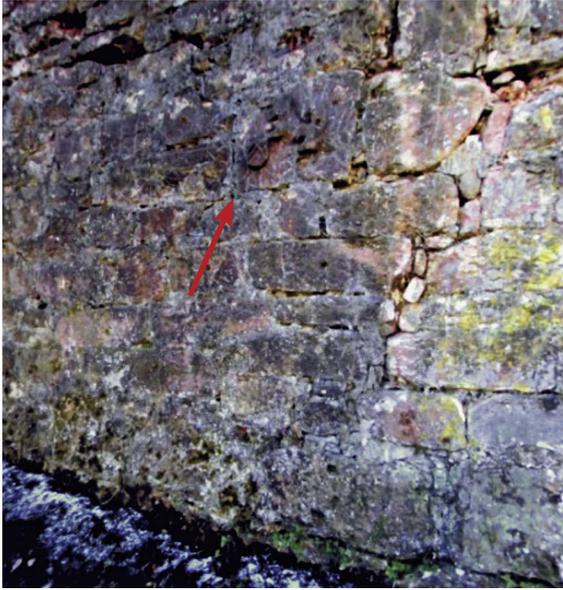
8 Lindenplatz, Nordkurtine. Ansicht von Nordwesten. Beispiel für eine der Baufugen zwischen Phase II und dem in Phase III reparierten Mauerwerk mit eingefügtem Wappenstein (Pfeil).
