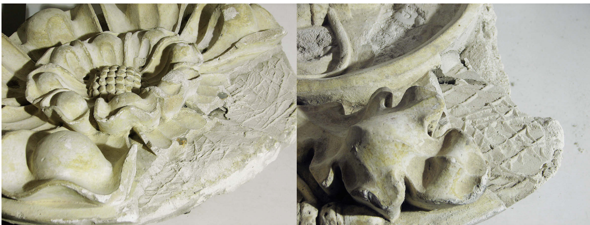
3 Details von Schlusssteinen der Katharinenkirche Oppenheim aus Gips mit feinem Obermaterial, größerem Anbringungsmaterial und Abdruck der aufgerauten Oberfläche zu deren besseren Verbindung.
