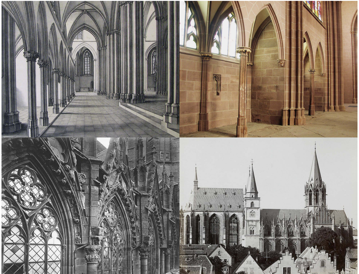
1 Ansichten der Katharinenkirche Oppenheim. Oben links: nördliche Seitenkapellen vor 1836; oben rechts: Nordseitenschiff mit zurückgesetzten Kapellen; unten links: Obergaden Südseite um 1877; unten rechts: Zustand der Südseite nach der Restaurierung Ende des 19. Jahrhunderts.
