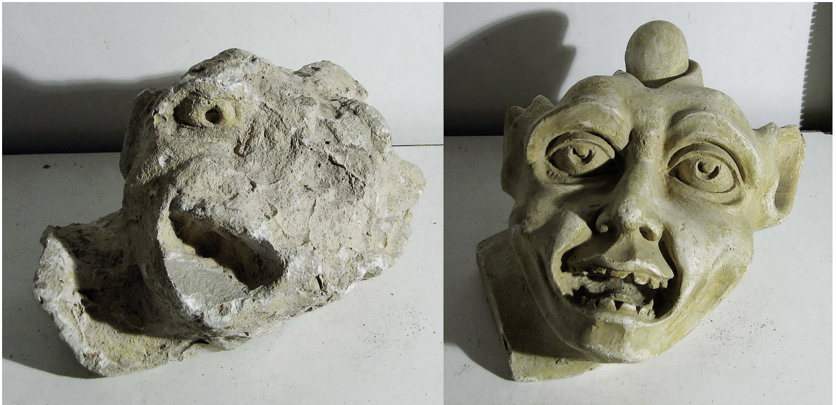
11 Droherie aus dem vierten Joch des Obergadens an der Südseite der Katharinenkirche Oppenheim. Links: Abguss des verwitterten Kopfs um 1880; rechts: Modell nach dem Abguss um 1880.
