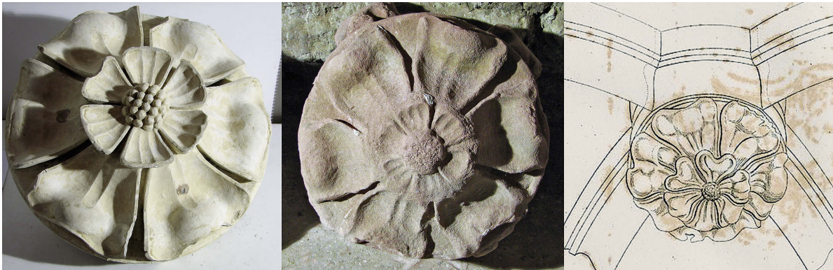
2 Schlussstein aus dem Langhaus der Katharinenkirche Oppenheim. Links: Gips um 1840; Mitte: originaler Schlussstein; rechts: Zeichnung des Schlusssteins um 1830.
