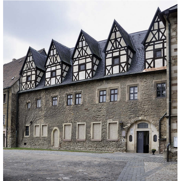
2 Klausurflügel. Zwei steinerne Geschosse und Fachwerkgiebel mit den Mönchszellen. Blick von Nordosten (Foto 2012).
