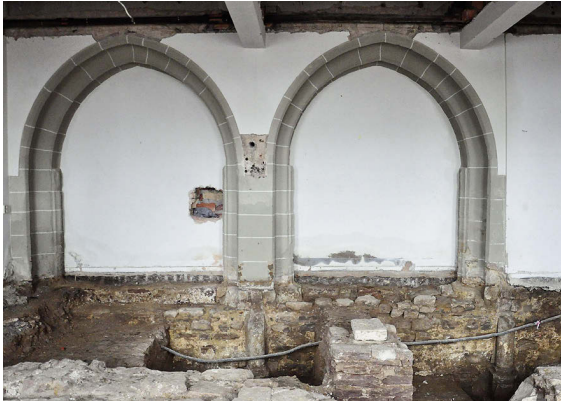
6 Klausurflügel, Erdgeschoss, ehemaliger Speisesaal und noch vermauerte Kreuzgangarkaden, unterhalb der Arkaden die Mauerreste der ersten Bauphase mit den damals versetzten Wandsäulen und mit diesen baueinheitlich versetzten unteren Werksteinen der Arkaden. Blick von Nordosten (Foto 2013).
