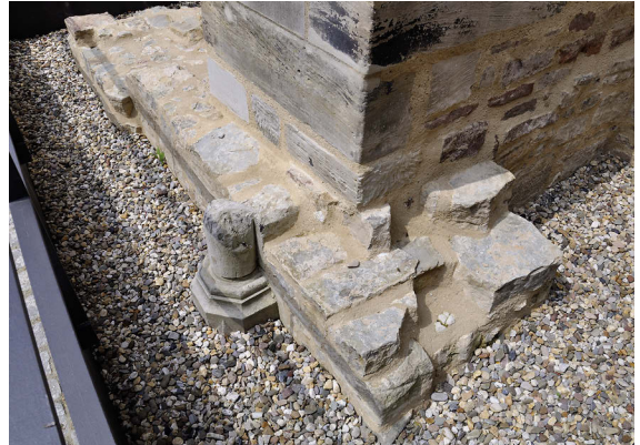
7 Kirche, erster Strebe Pfeiler westlich des Klausurgebäudes mit freigelegter Wandsäule der ersten Bauphase. Der Pfeiler sitzt auf dem Fundament der Nordwand eines geplanten Klausurnordflügels. Blick von Südosten (Foto 2016).
