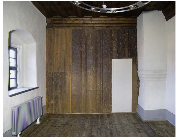
15 Klausurflügel, Obergeschoss, südliche Bohlenstube der Bauphase 2 nach der Instandsetzung (Foto 2018).
