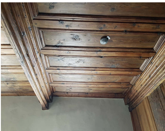
16 Klausurflügel, Obergeschoss. Südliche Bohlenstube der Bauphase 2 nach der Instandsetzung: weitgehend erhaltene südliche Bohlenwand und Decke mit umlaufendem Wandgesims sowie Unterzug. Blick von Westen (Foto 2018).
