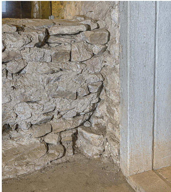
15 Die Mauer (II fm+am 4, links) stößt stumpf gegen die Nordmauer (II fm+am 5, rechts) des südlichen Kryptenstollens, Blick von Nordwesten.
