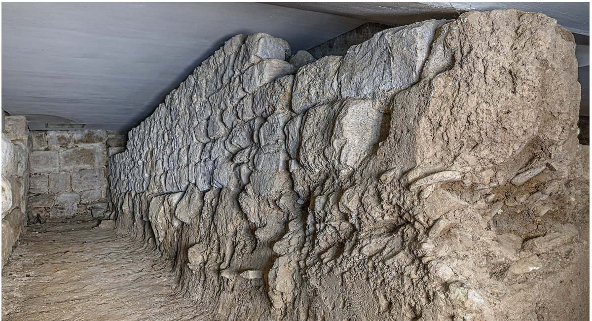
5 Nördlicher Kryptenstollen, westlicher Abschnitt (II fm+am 10) der Südmauer, Blick von Westen.
