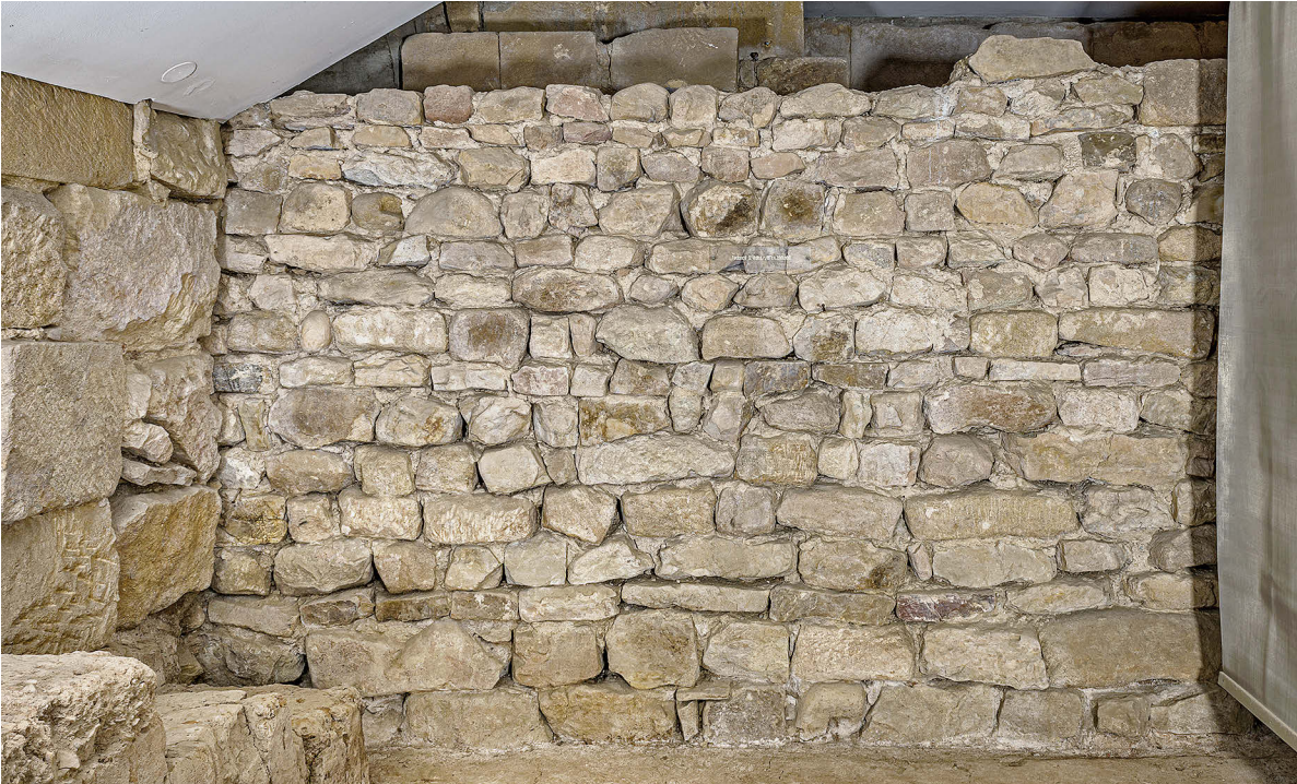
17 Die ursprünglich nicht sichtbare Südseite der Südmauer des nördlichen Kryptenstollens (II fm+am 3) im heutigen leeren Museumsraum im Bereich der ehemaligen Confessio, Blick von Süden.
