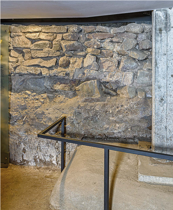
18 Das Mauerwerk im westlichen Bereich der Südmauer des nördlichen Kryptenstollens (II fm+am 10), Blick auf die gegen Erde gesetzte Südseite.
