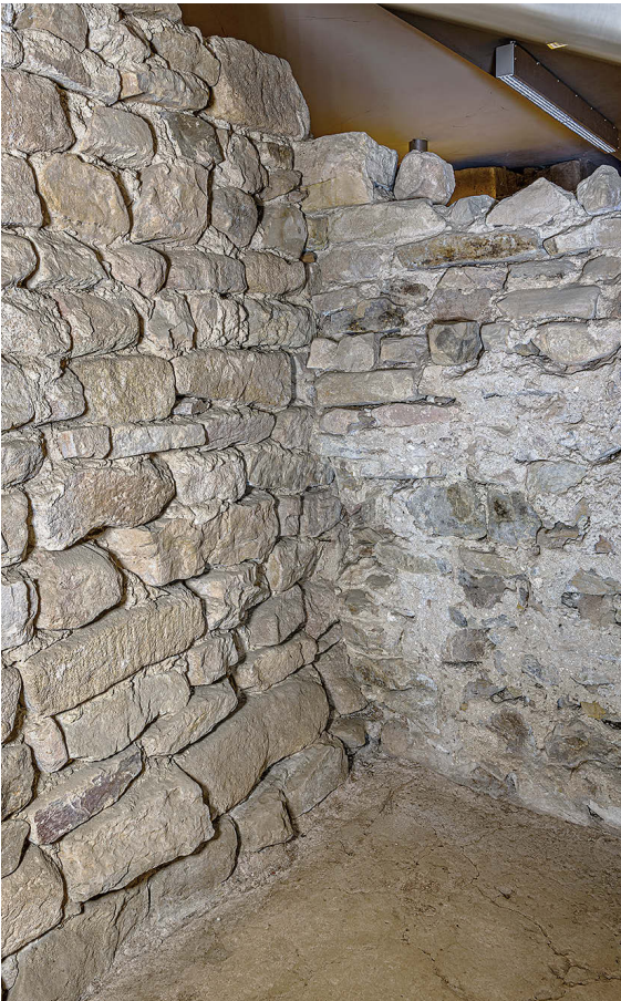
14 Die Mauer (II fm+am 4, rechts) stößt stumpf gegen die Südmauer (II fm+am 3) des nördlichen Kryptenstollens und verzahnt erst auf Höhe des Gewölbeansatzes, Blick von Südwesten.
