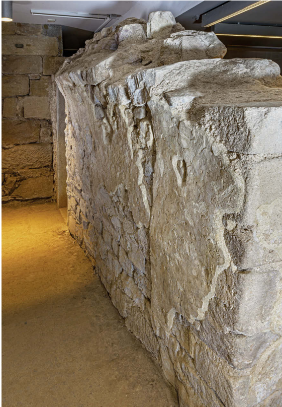
3 Südlicher Kryptenstollen, östlicher Abschnitt (II fm+am 5) der Nordmauer, Blick von Südosten.
