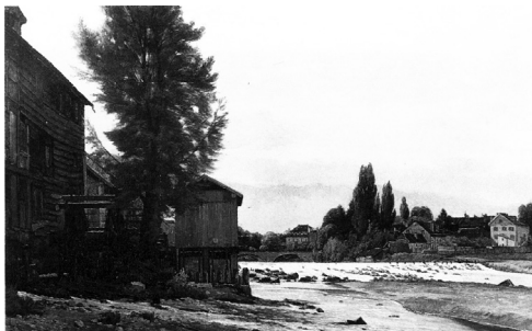
Joseph Rérolle, Alte Mühle und Ortschaft am Fluss , 77 × 104 cm (Aukt.-Kat. München, Neumeister, Auktion 265, 11. 12. 1991, 567)
