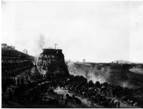
Jean-Baptiste Louis Moullin, Démolition des fortifications de Paris, près du Trocadéro, avec la visite officielle de Napoléon III et d'Eugénie , 1867, 84 × 111 cm (Aukt.-Kat. Monaco, Sotheby's, 16. 6. 1990, 729)
