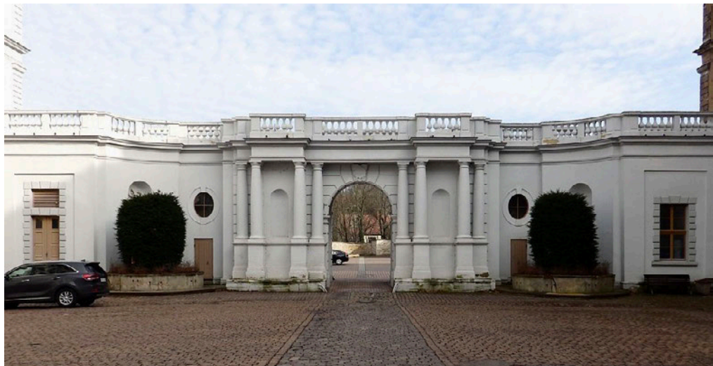
10 Ansicht von Schloss Neu-Augustusburg in Weißenfels mit der den Hof abschließenden Eingangsfront, Blick vom Hof
