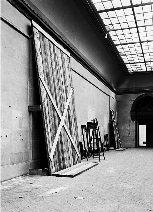
3 Marc Vaux, Salle des Sept Mètres at the Louvre, 1939
