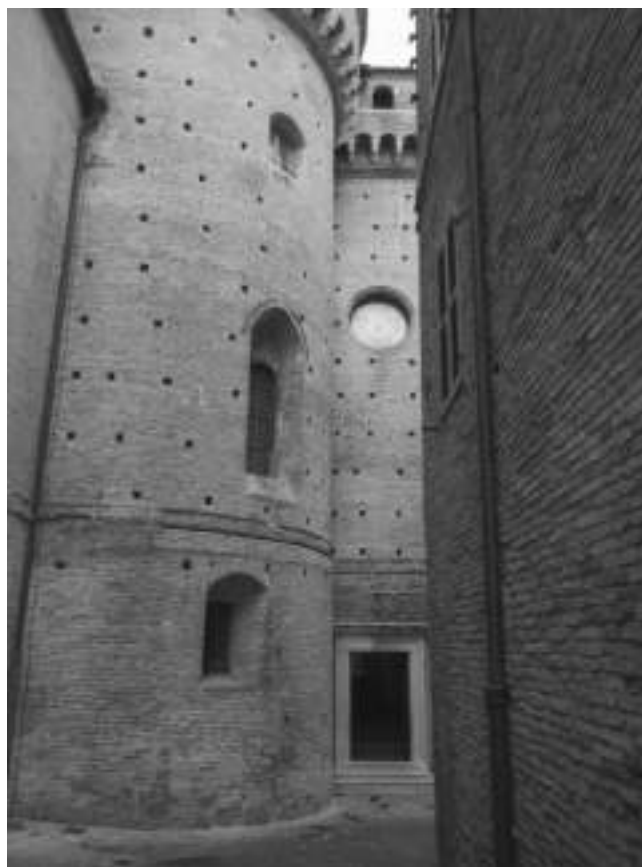
Torre sudoccidentale con parete occidentale del braccio meridionale
