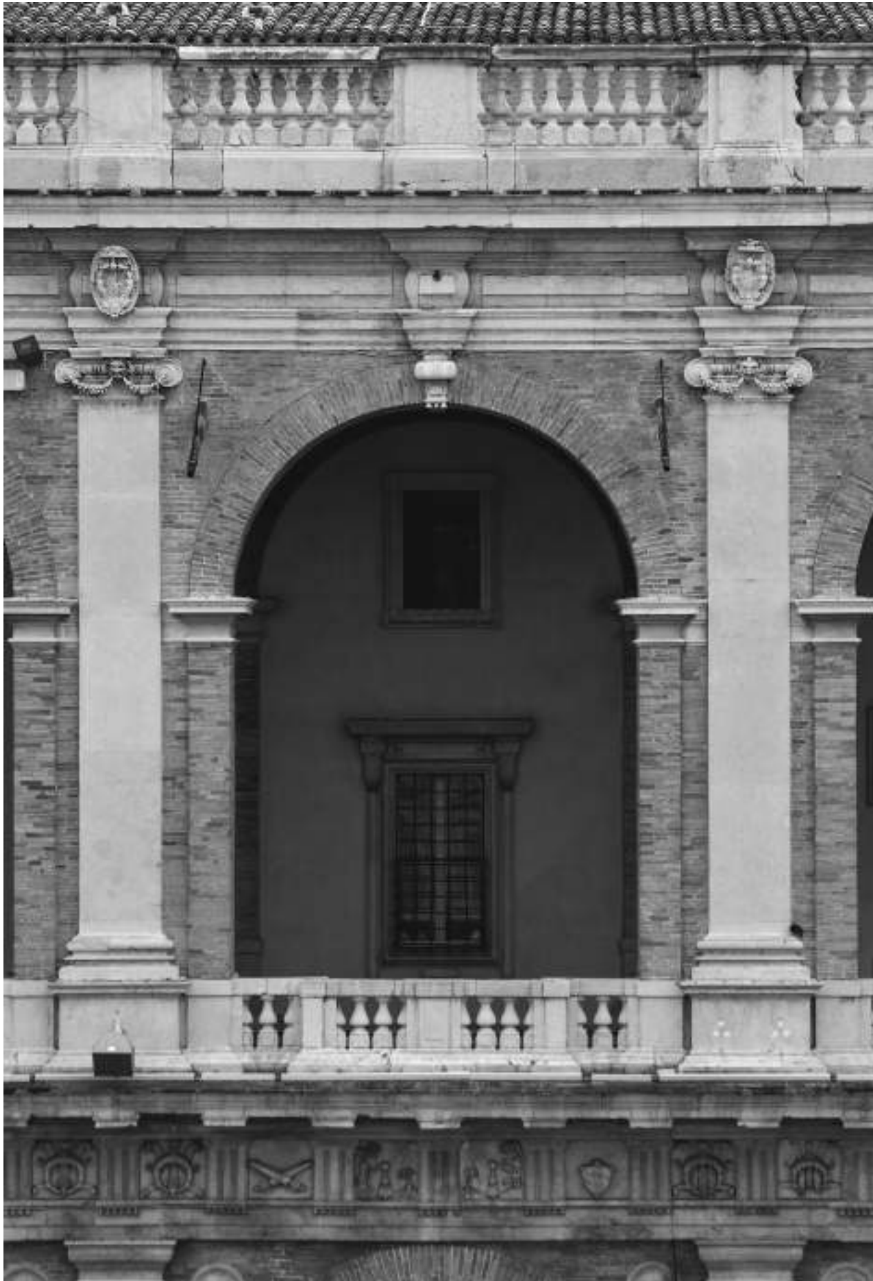
Campata del piano superiore dell'ala nord della loggia
