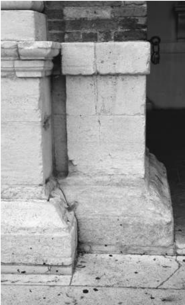
141 Piedistallo di una delle prime campate della loggia settentrionale
