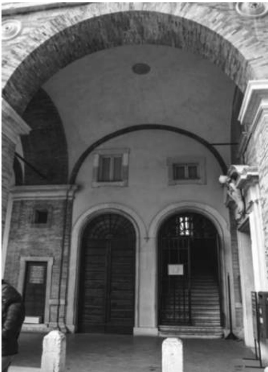
Arcate della scala orientale nel pianterreno della loggia nord
