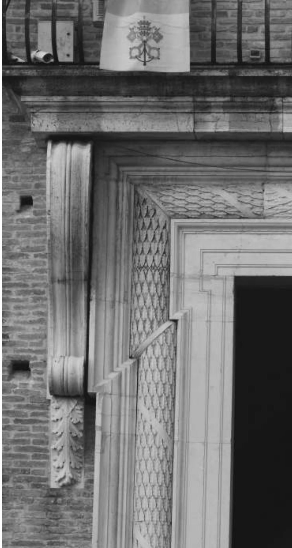
Portale sangallesco della chiesa, dettaglio
