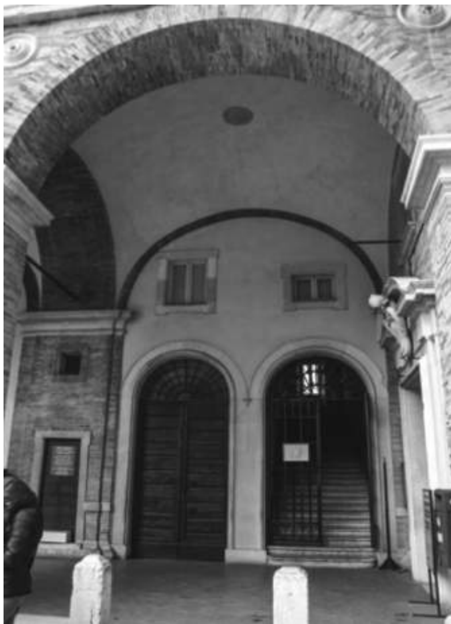
Arcate della scala orientale nel pianterreno della loggia nord
