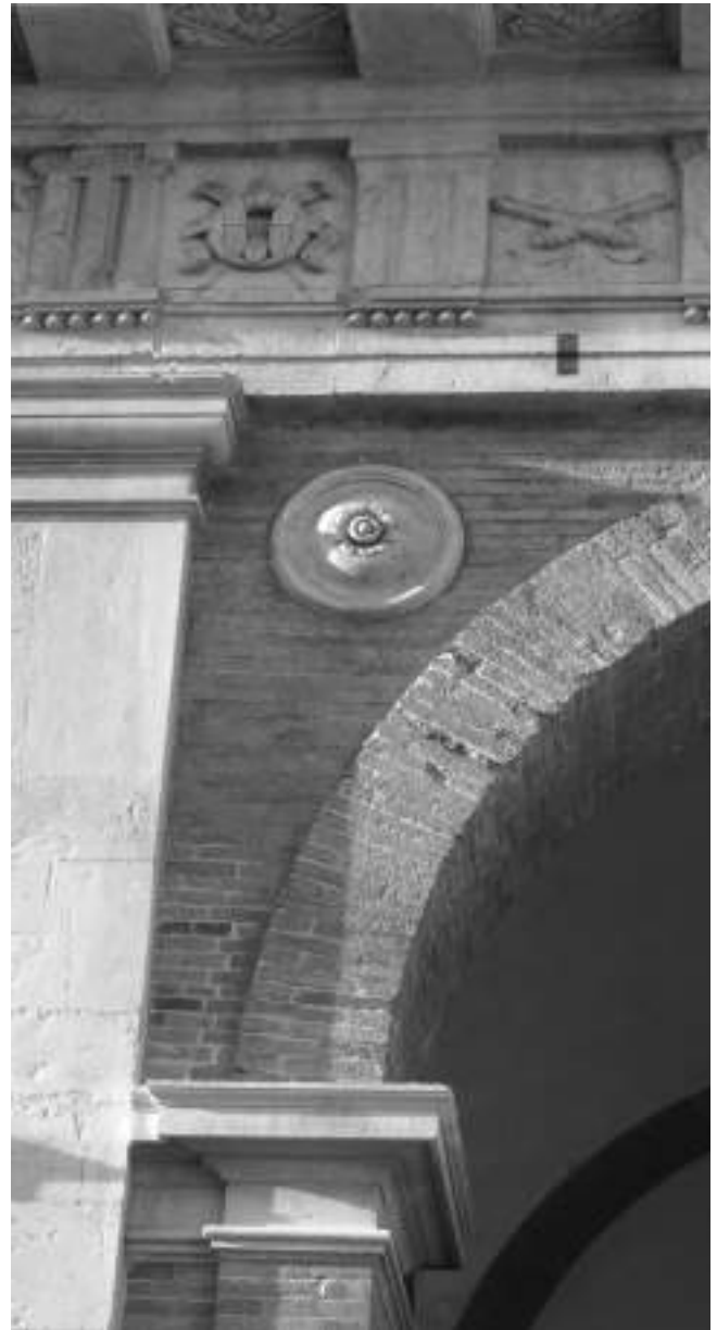
142 Dettaglio di una delle prime campate del pianterreno della loggia settentrionale
