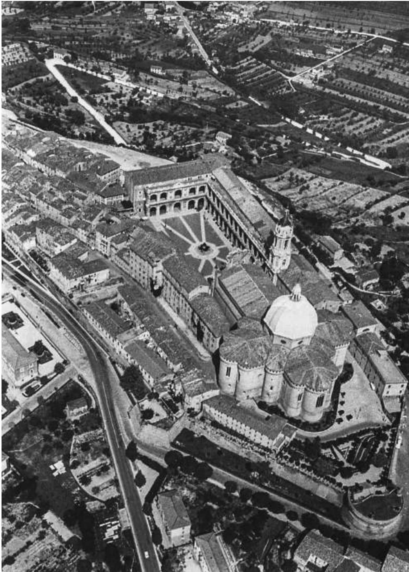
Veduta aerea del santuario da sudest
