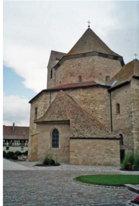
Abb. 4 Die Kirche von Ottmarsheim zeigt bis heute den achteckigen Grundriss der Gründungsanlage, typologisch angelegt an die karolingische Pfalzkapelle in Aachen. Das Damenstift ist nie zu einer grossen Abtei gewachsen und hat deshalb die ursprüngliche Struktur bewahrt.
