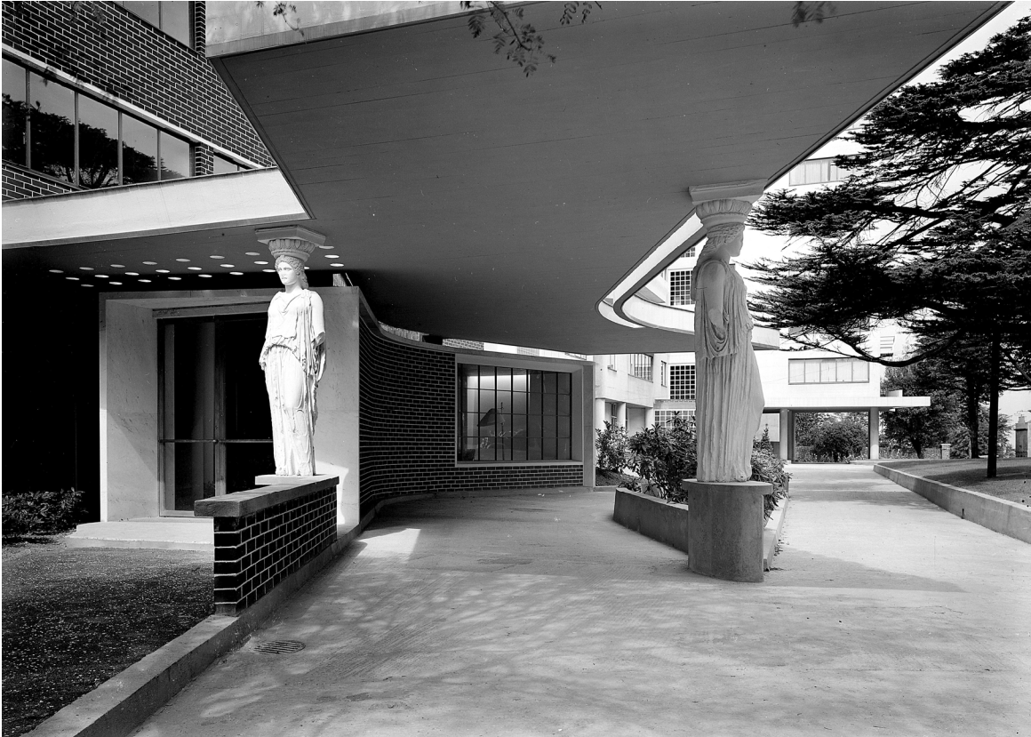
Abb. 3: Berthold Lubetkin, Eingangspartie zum Wohnblock Highpoint II, London, 1935–1938, im Hintergrund der Eingang zu Highpoint I, RIBA8766.
