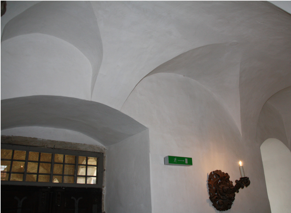
□ 13 Westliches Treppenhaus. Westwand mit dem ursprünglichen Gewölbe. Foto und Bearbeitung: Jan-Eric Lutteroth, Mai 2019.
