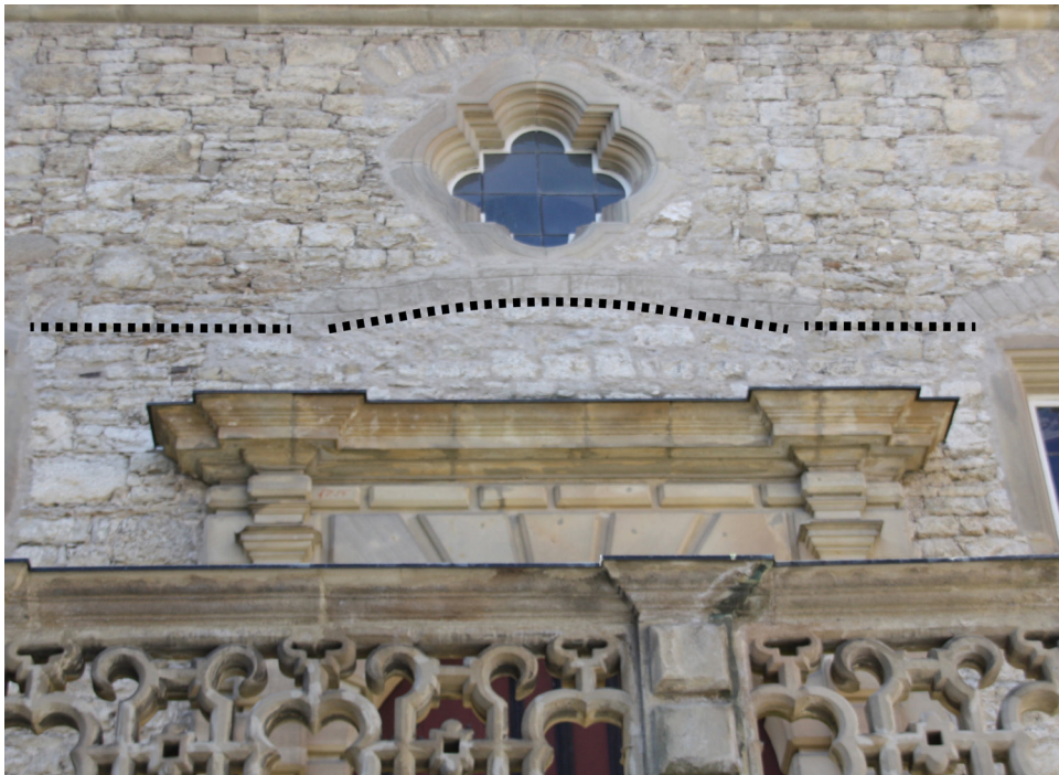
□ 10 Nordfassade des Saalbaus. Hervorhebung des Entlastungsbogens des ehemaligen mittleren Saalfensters. Foto und Bearbeitung: Jan-Eric Lutteroth, Mai 2019.
