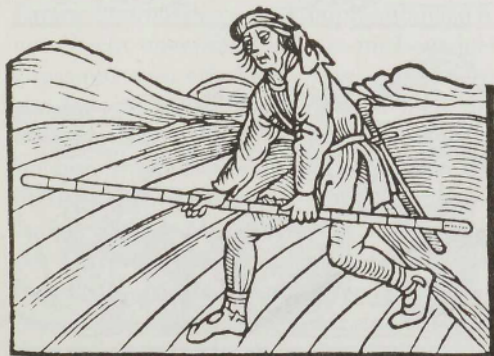
Abb. 3. Gebrauch einer Meßstange (aus I. KÖBEL (Anm. 40))
